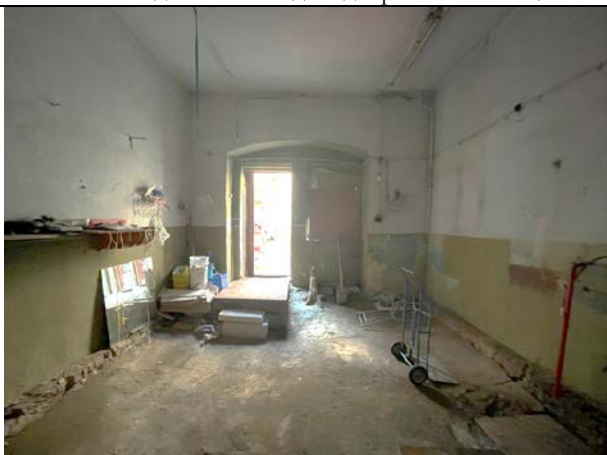
Фото 23. Типичное состояние Объекта оценки
