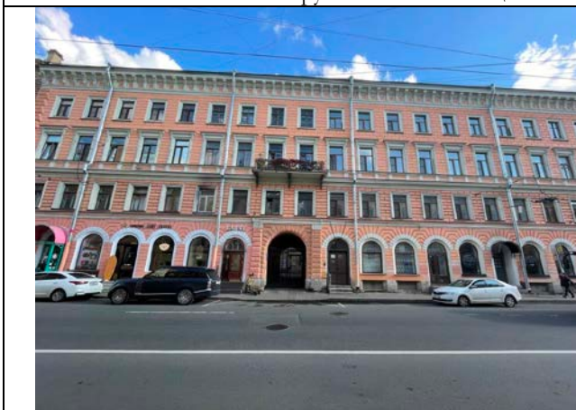
Фото 15. Вид здания расположения Объекта оценки
