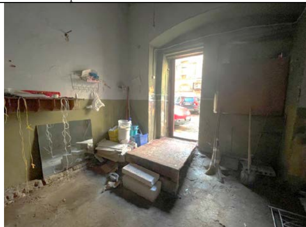
Фото 22. Типичное состояние Объекта оценки
