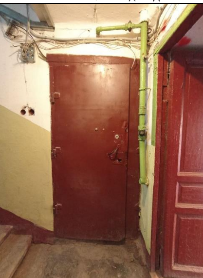
Фото № 9 – Дверь в помещение
