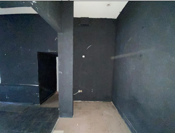
Фото № 10 – Внутреннее состояние помещения
