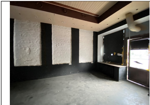
Фото № 7 – Внутреннее состояние помещения
