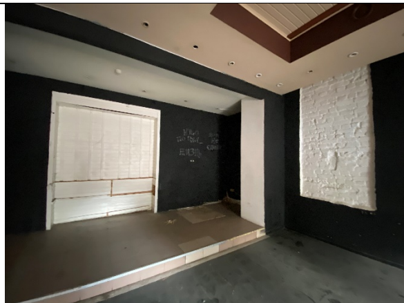
Фото № 8 – Внутреннее состояние помещения
