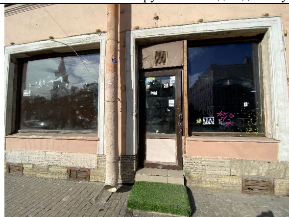
Фото № 4 – Вход в помещение с улицы
