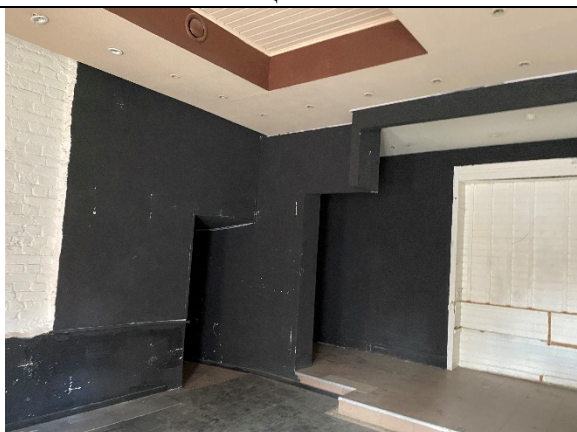
Фото № 5 – Внутреннее состояние помещения
