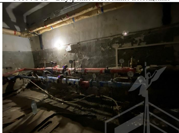
Фото № 14 – Внутреннее состояние помещения
