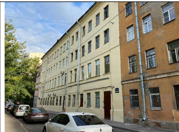
Фото № 1 – Ближайшее окружение и подъездные пути
