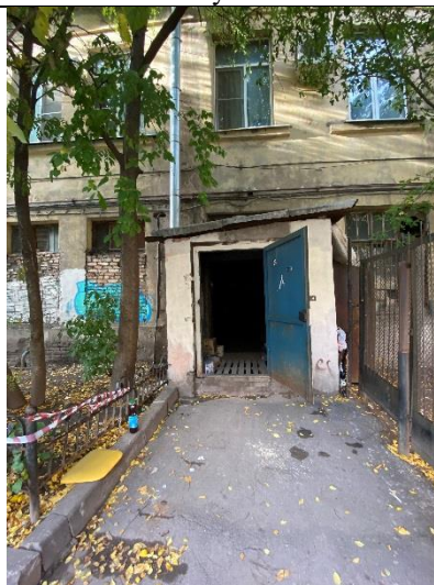
Фото № 4 – Вход в помещение со двора
