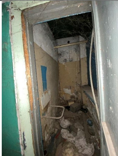
Фото № 16 – Внутреннее состояние помещения
