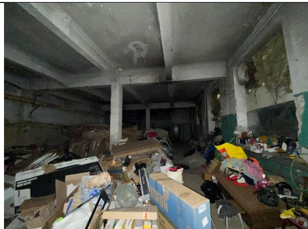
Фото № 8 – Внутреннее состояние помещения
