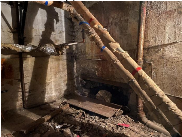
Фото № 17 – Внутреннее состояние помещения
