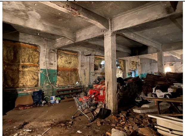
Фото № 18 – Внутреннее состояние помещения
