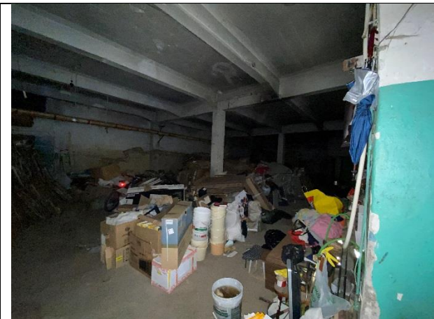
Фото № 7 – Внутреннее состояние помещения
