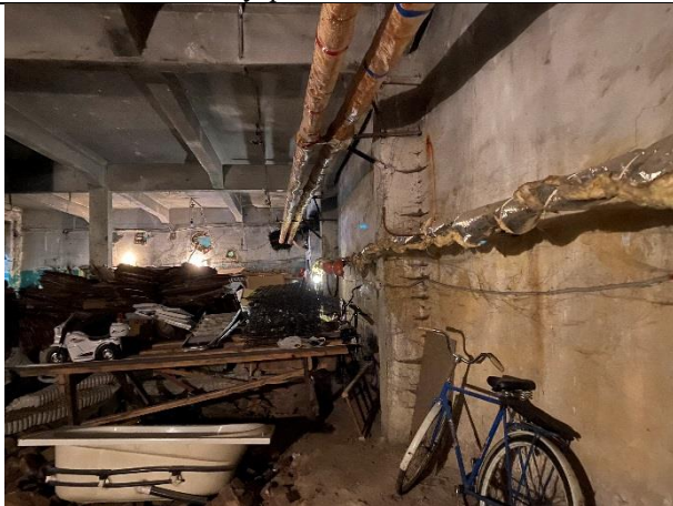
Фото № 19 – Внутреннее состояние помещения
