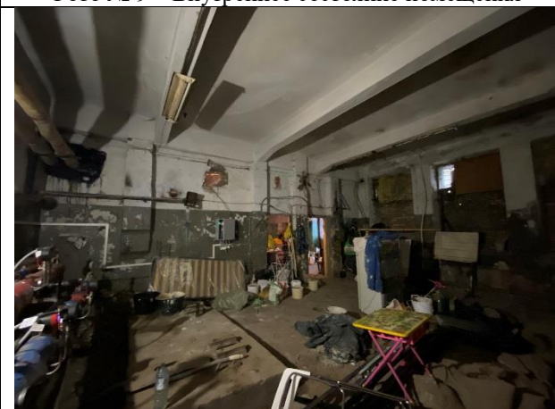
Фото № 11 – Внутреннее состояние помещения
