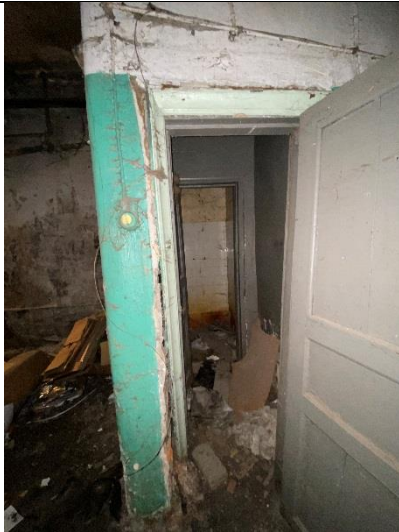
Фото № 15 – Внутреннее состояние помещения
