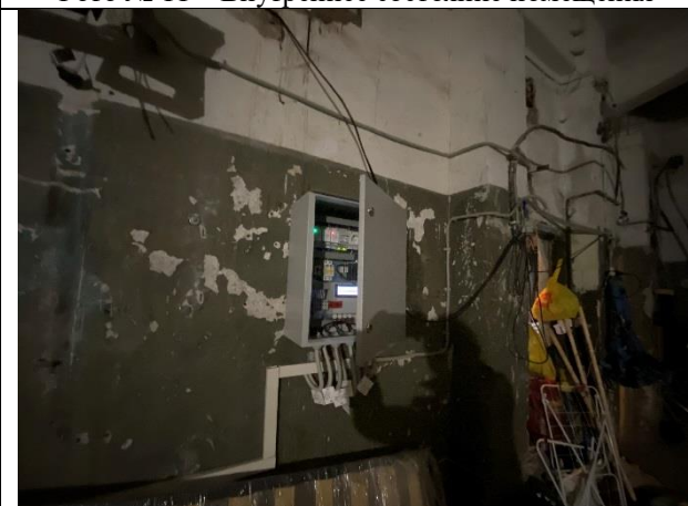
Фото № 13 – Внутреннее состояние помещения
