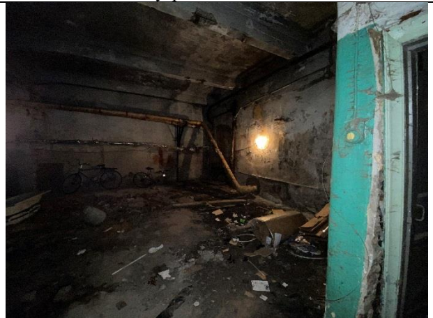
Фото № 20 – Внутреннее состояние помещения
