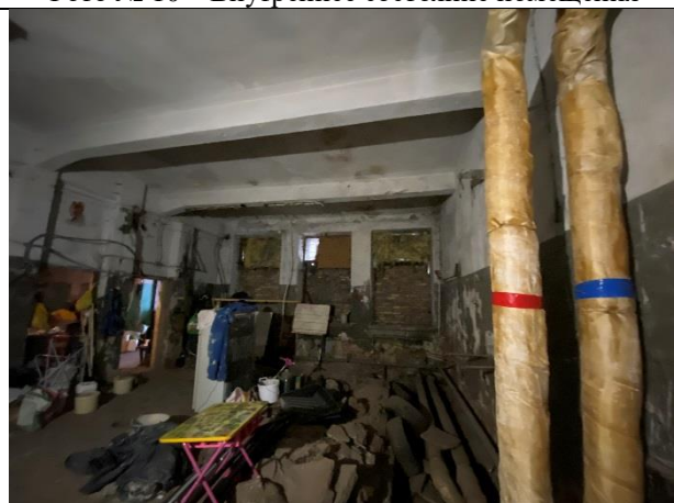
Фото № 12 – Внутреннее состояние помещения
