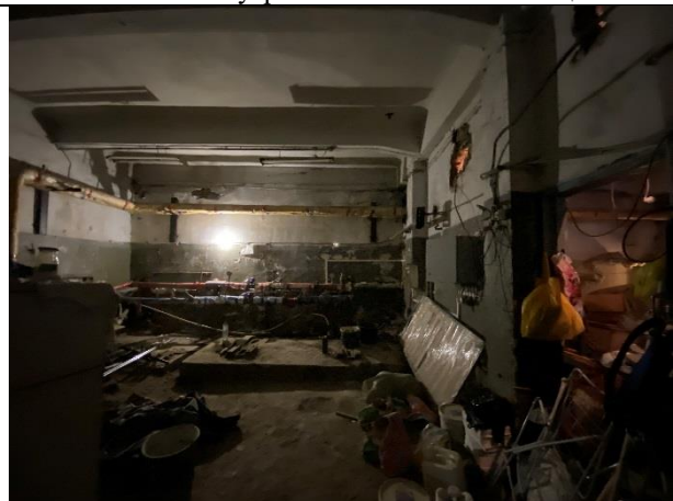
Фото № 10 – Внутреннее состояние помещения
