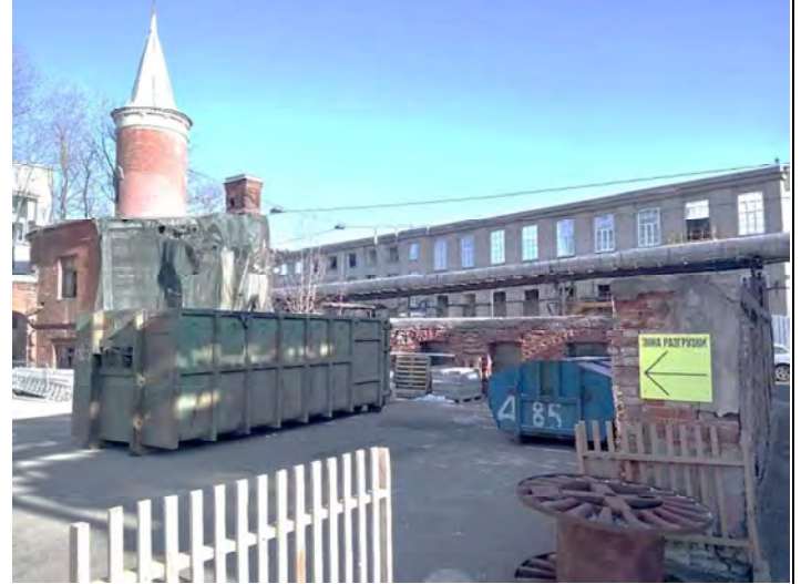
Фото № 7. Вид с юго-восточного угла
