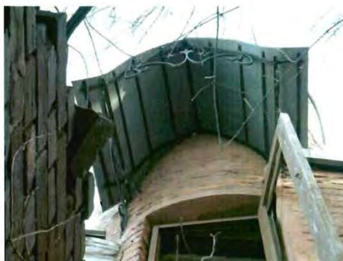
2. Навес над дверным проемом со стороны двора.
