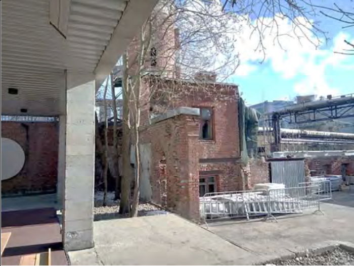
Фото № 19. Вид Западной части и Южного фасада с юго-западного угла
