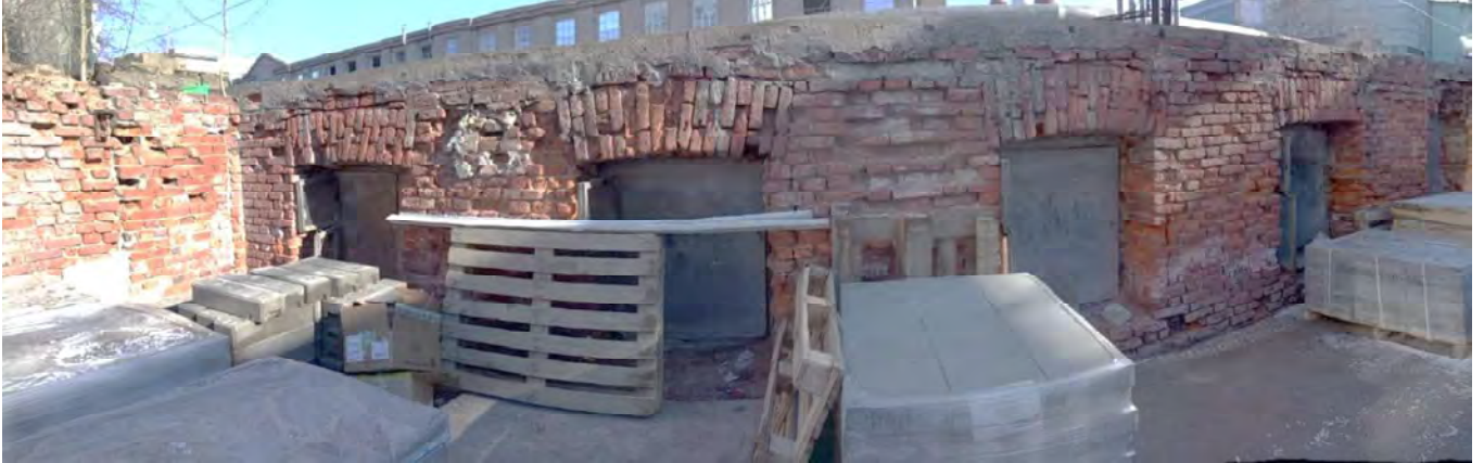
Фото № 12. Панорамный вид из северо-восточного угла цокольного этажа
