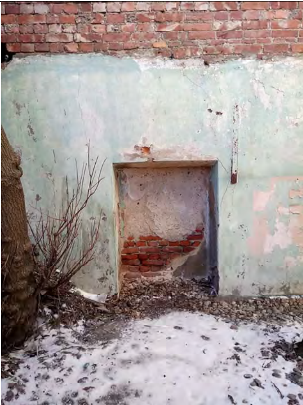
Фото № 24. Вид части стены цокольного этажа с заложеным оконным проемом Западной части Здания
