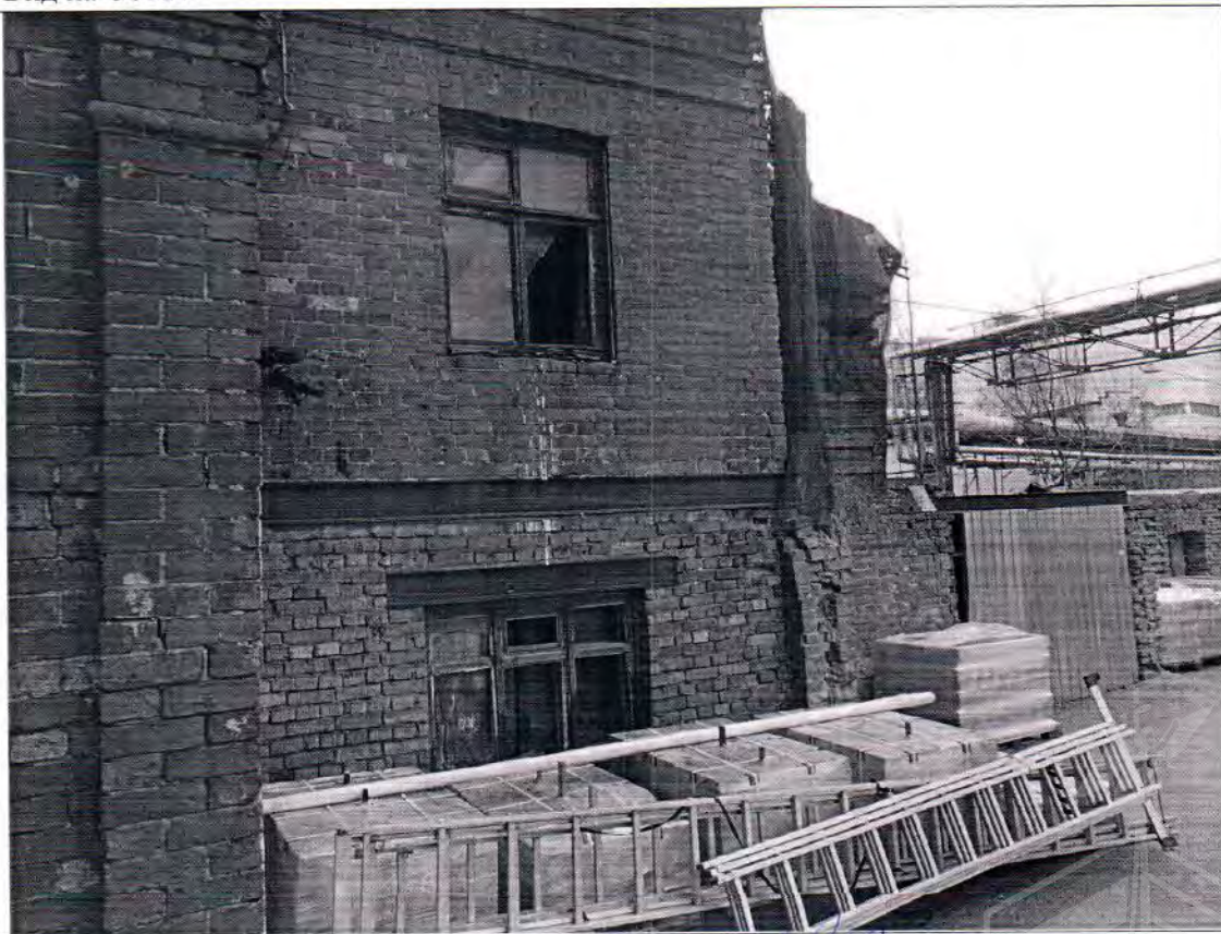
Описание: Вид на Объект
