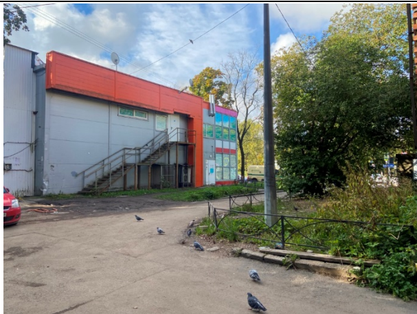
Фото № 1. Подъездные пути и окружение объекта
