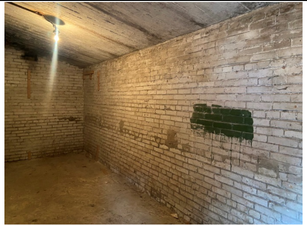
Фото № 12. Внутреннее состояние здания
