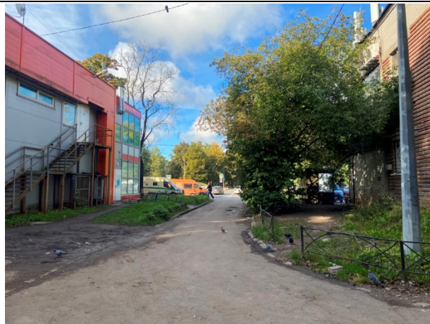
Фото № 2. Подъездные пути и окружение объекта
