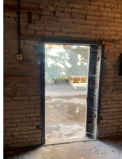
Фото № 10. Внутреннее состояние здания
