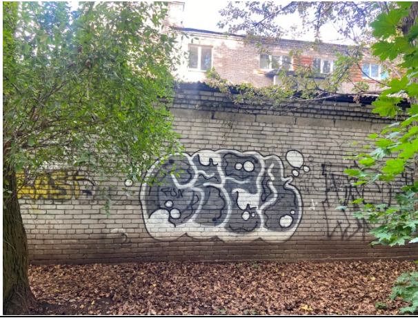
Фото № 7. Внешний вид здания
