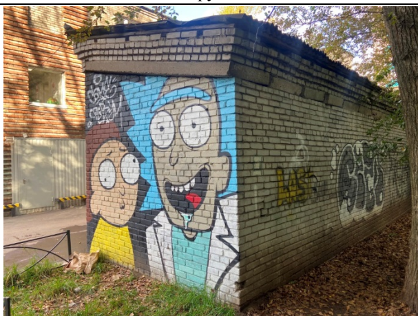
Фото № 5. Внешний вид здания
