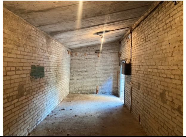
Фото № 8. Внутреннее состояние здания
