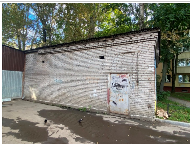
Фото № 6. Внешний вид здания
