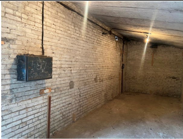
Фото № 11. Внутреннее состояние здания
