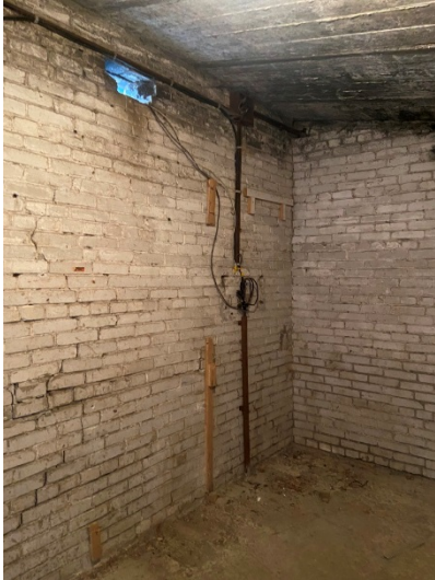
Фото № 9. Внутреннее состояние здания
