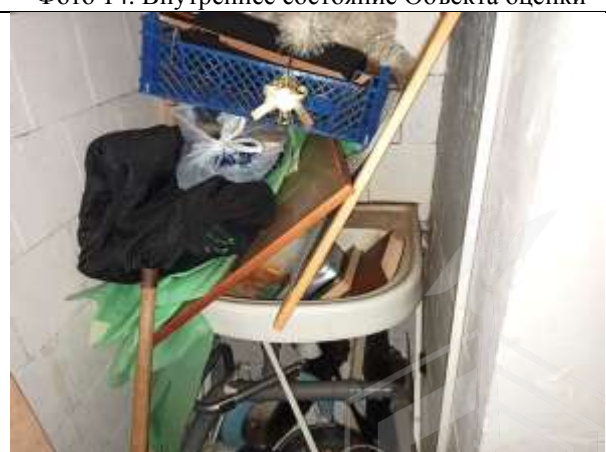
Фото 16. Внутреннее состояние Объекта оценки
