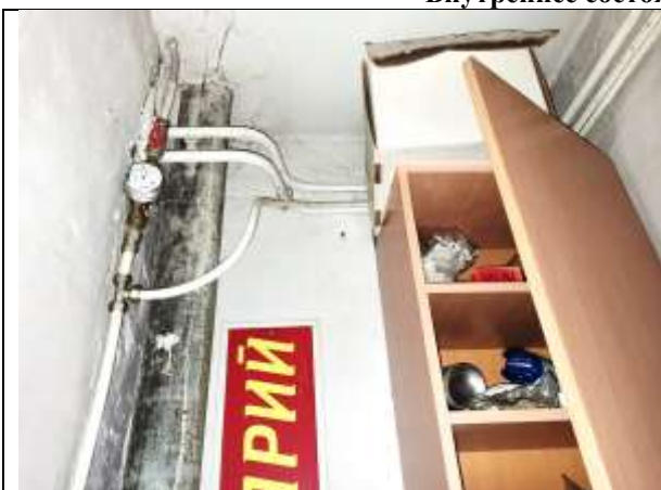
Фото 7. Внутреннее состояние Объекта оценки
