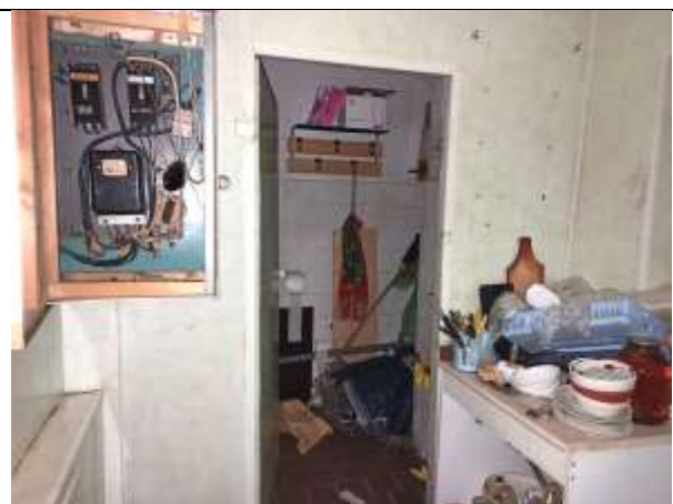
Фото 10. Внутреннее состояние Объекта оценки
