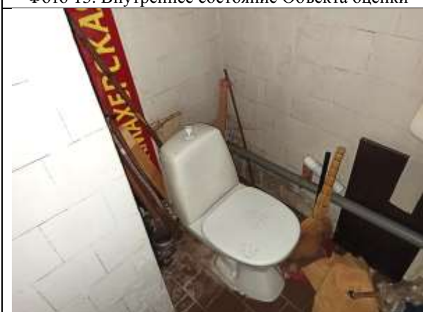
Фото 15. Внутреннее состояние Объекта оценки
