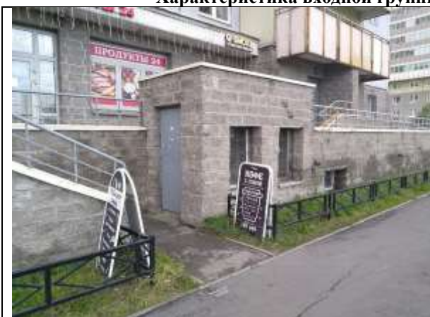
Фото 7 Отдельный вход с улицы
