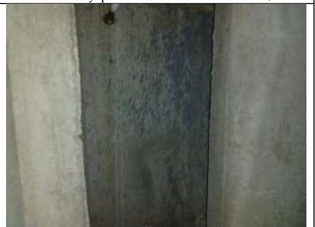
Фото 26. Внутреннее состояние Объекта оценки
