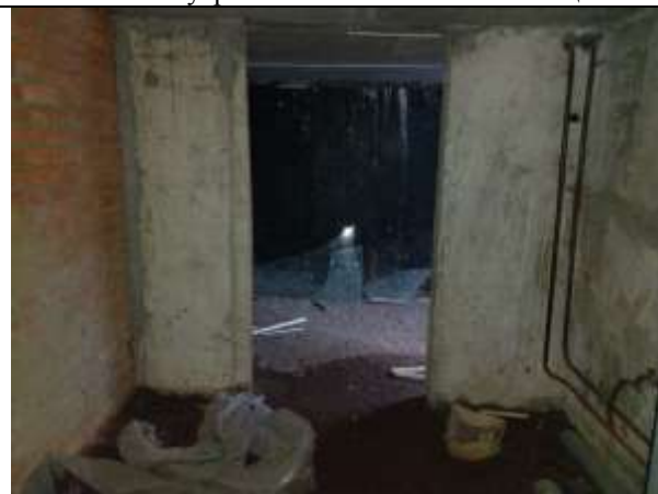
Фото 19. Внутреннее состояние Объекта оценки
