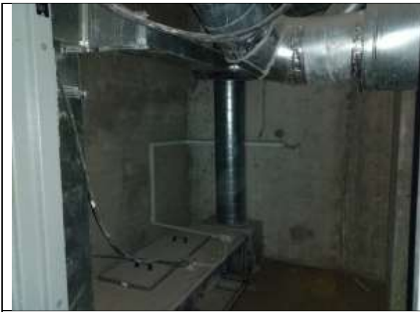
Фото 23. Внутреннее состояние Объекта оценки
