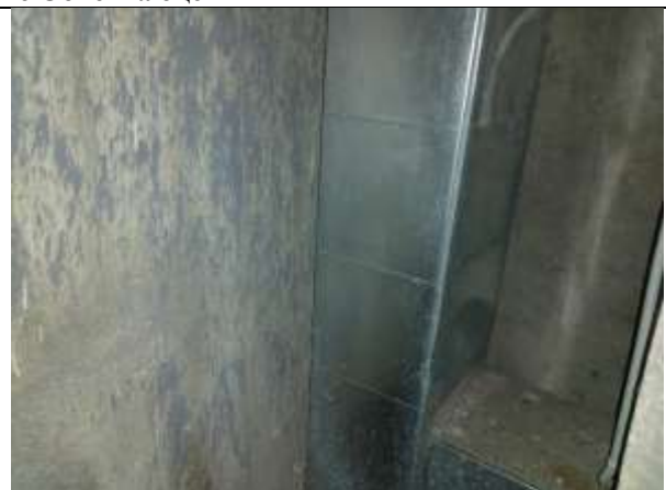
Фото 12. Внутреннее состояние Объекта оценки
