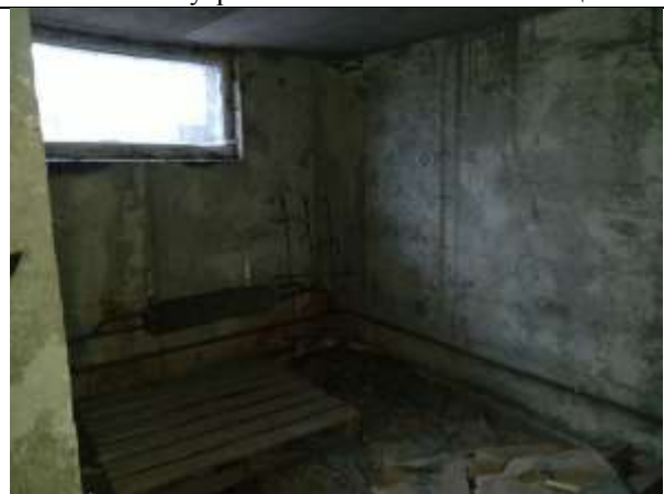
Фото 18. Внутреннее состояние Объекта оценки
