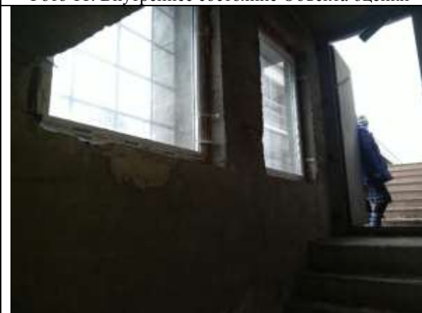
Фото 13. Внутреннее состояние Объекта оценки
