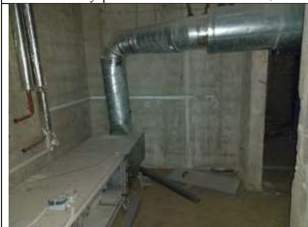
Фото 25. Внутреннее состояние Объекта оценки
