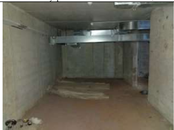
Фото 20. Внутреннее состояние Объекта оценки
