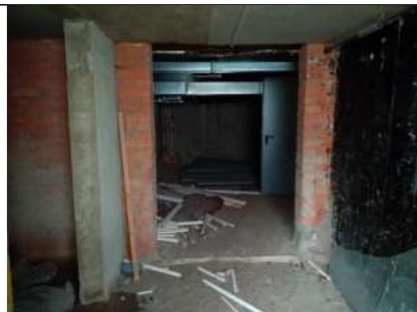
Фото 15. Внутреннее состояние Объекта оценки
