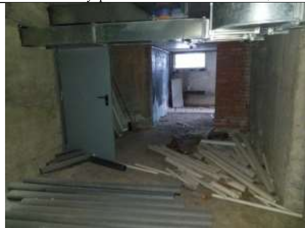
Фото 21. Внутреннее состояние Объекта оценки
