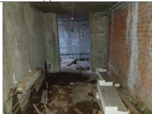
Фото 17. Внутреннее состояние Объекта оценки
