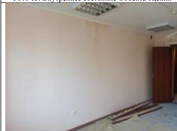
Фото 15. Внутреннее состояние Объекта оценки
