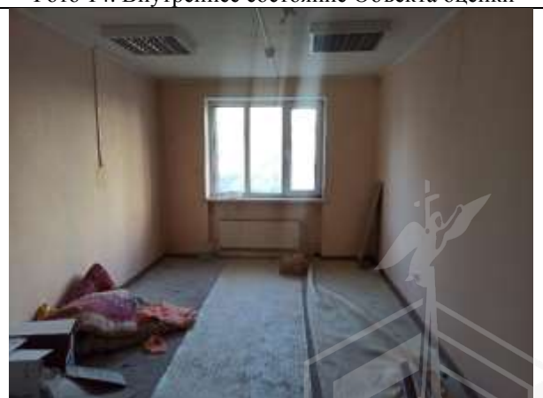
Фото 16. Внутреннее состояние Объекта оценки
