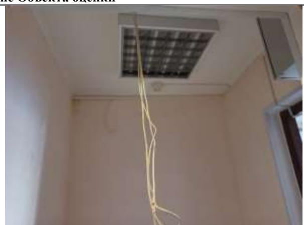
Фото 8. Внутреннее состояние Объекта оценки
