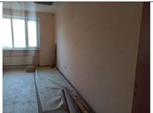
Фото 10. Внутреннее состояние Объекта оценки
