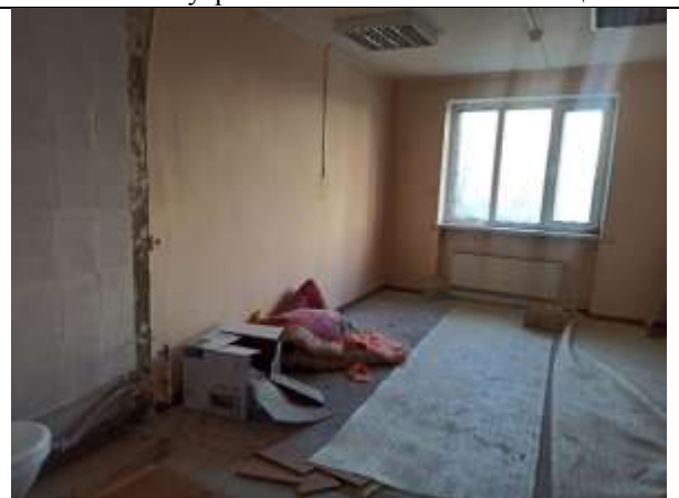
Фото 12. Внутреннее состояние Объекта оценки
