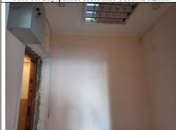
Фото 13. Внутреннее состояние Объекта оценки
