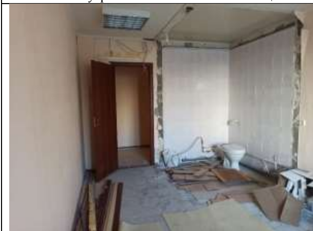
Фото 11. Внутреннее состояние Объекта оценки
