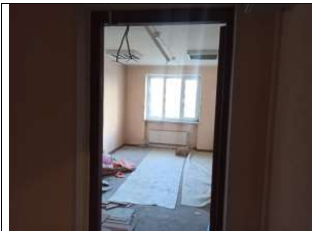
Фото 9. Внутреннее состояние Объекта оценки
