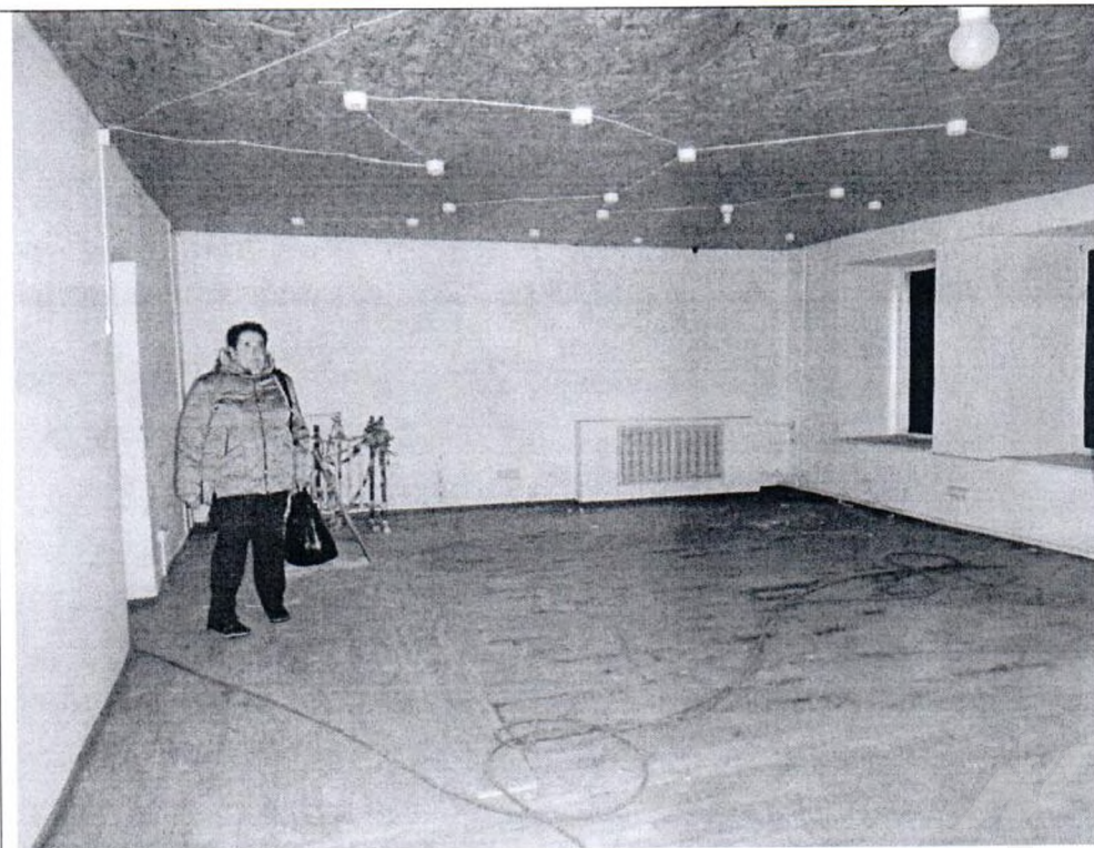
Описание: демонтированы перегородки между ч.п. 3 и ч.п. 4.
