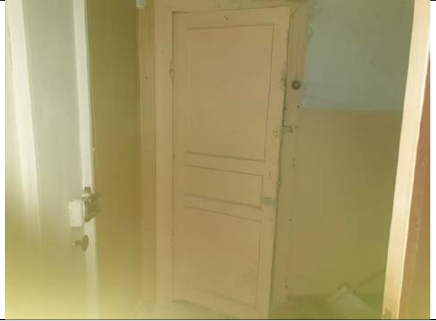
Фото № 8 – Вход в помещение
