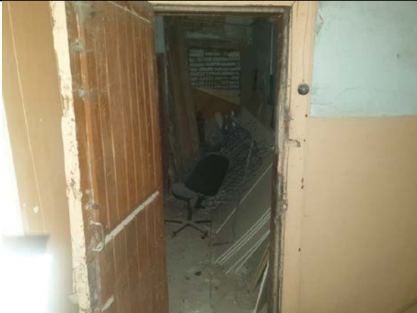
Фото № 9 – Вход в помещение
