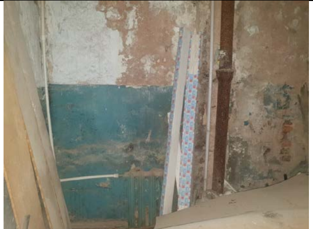
Фото № 10 – Вход в помещение
