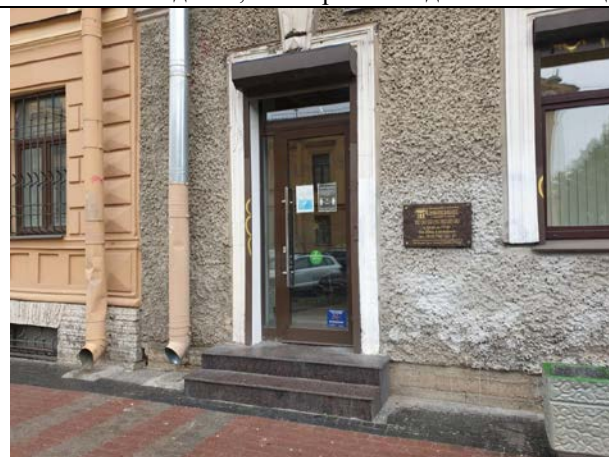
Фото № 6 – Вход в помещение (общий с улицы)
