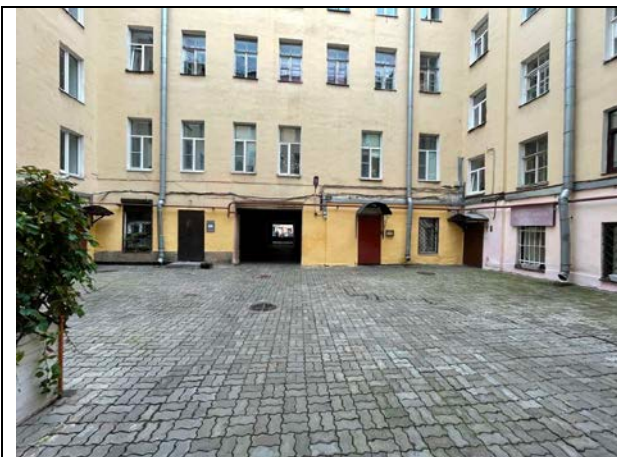
Фото 21. Внутри дворовая территория Объекта оценки
