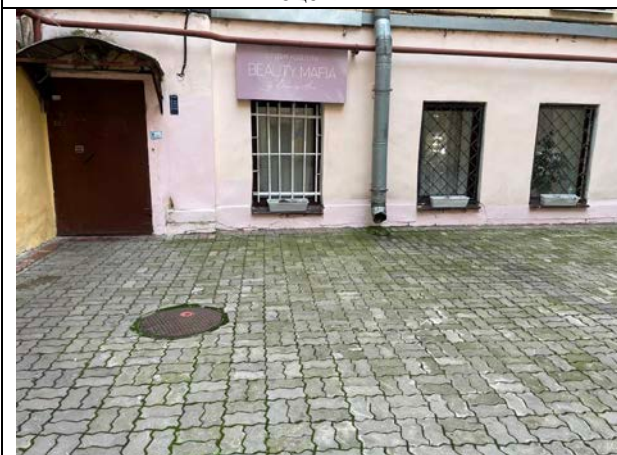
Фото 23. Внутри дворовая территория Объекта оценки
