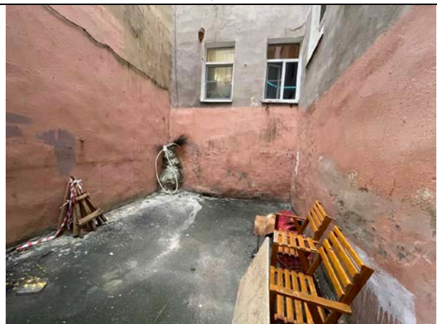
Фото 26. Внутри дворовая территория Объекта оценки
