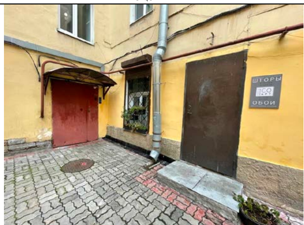
Фото 24. Внутри дворовая территория Объекта оценки
