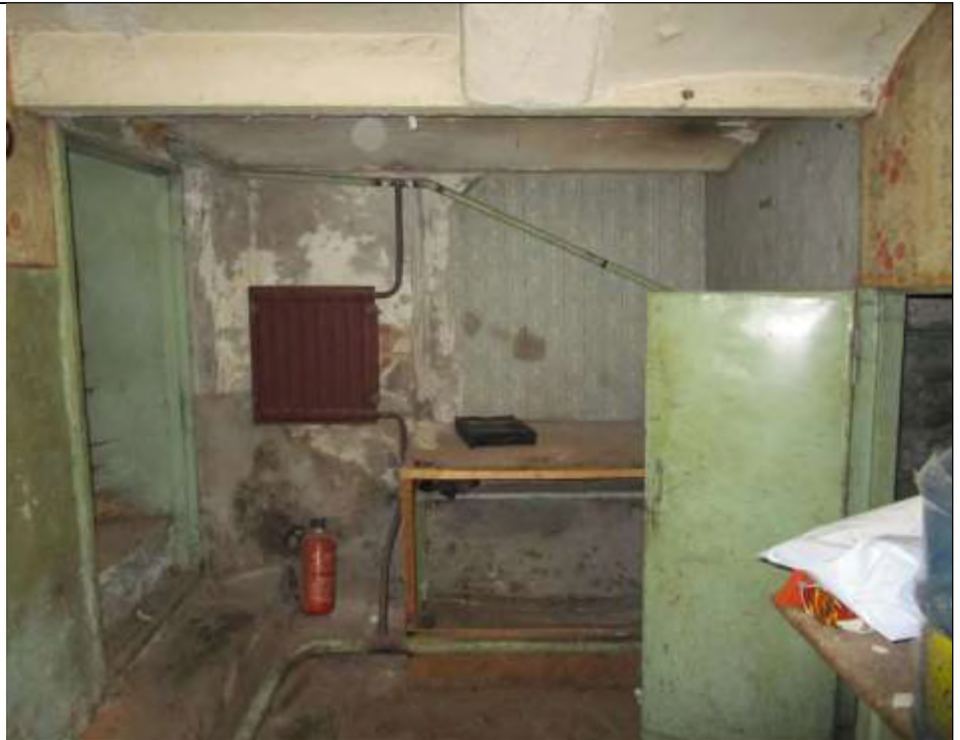
Описание: Вид внутри Объекта (ч.п. 2)
