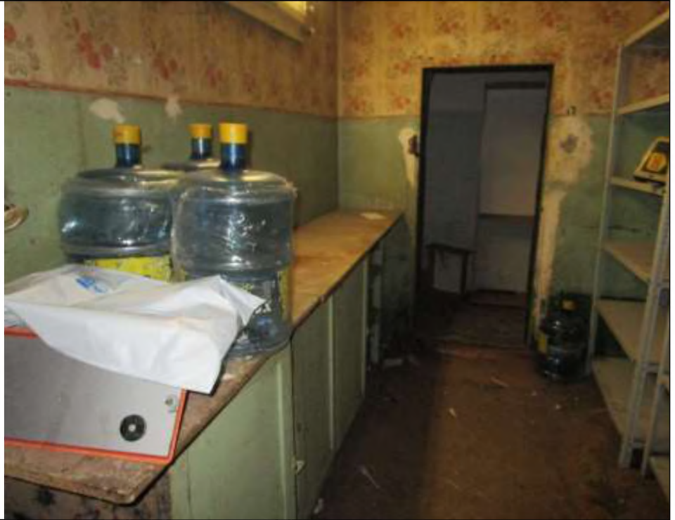
Описание: Вид внутри Объекта (ч.п. 2)
