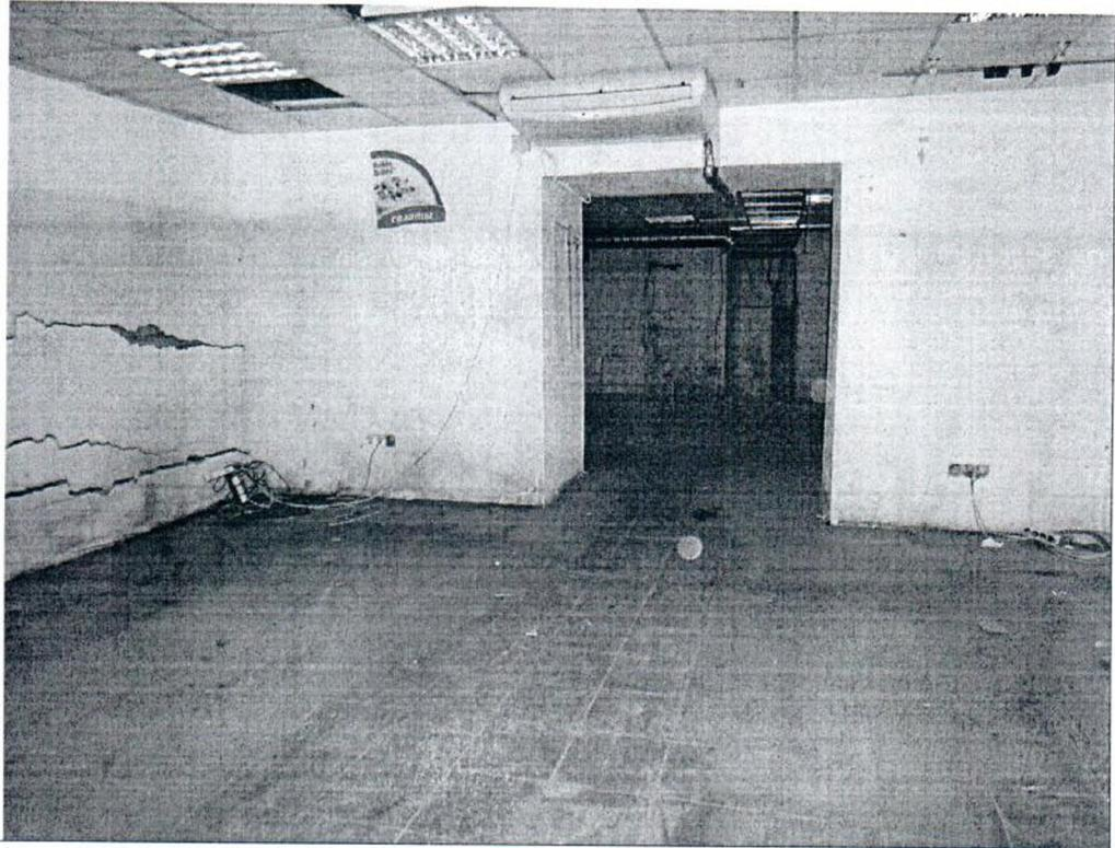
Описание: демонтирована часть перегородки (расширен проем в стене) между ч.п. 1 и ч.п. 2
