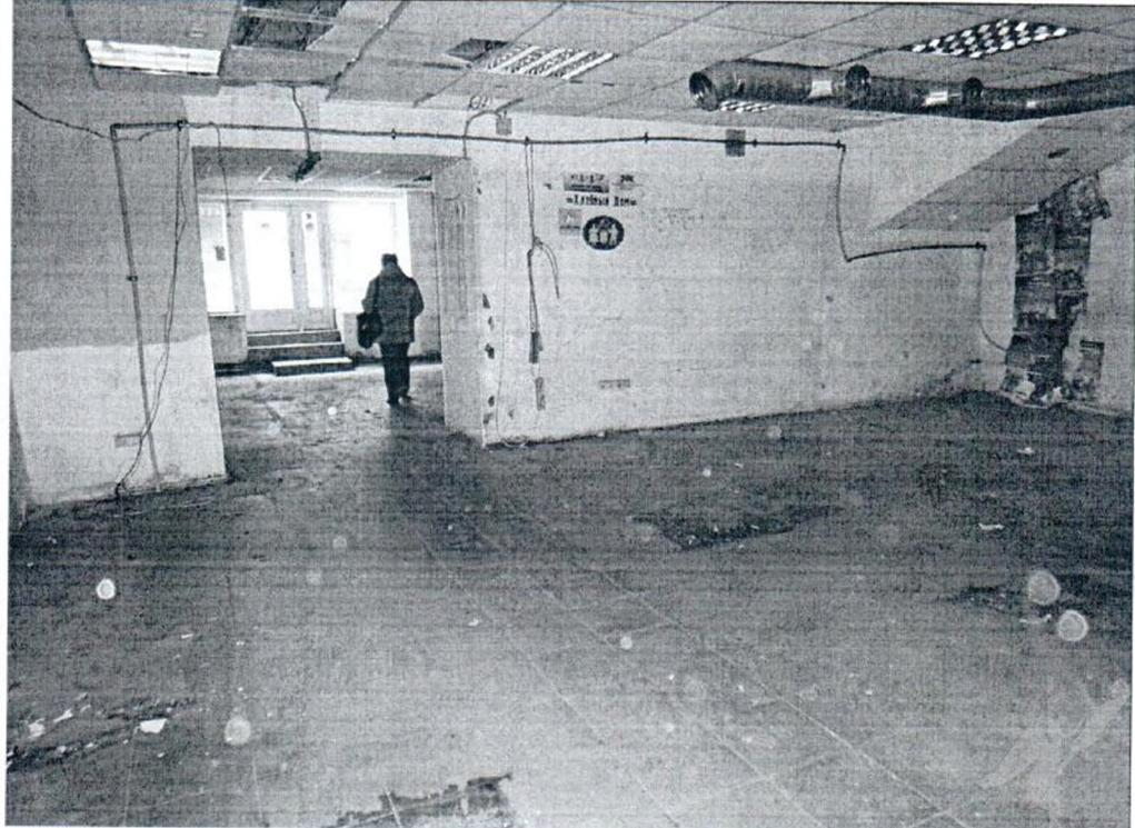
Описание: демонтирована часть перегородки (расширен проем в стене) между ч.п. 1 и ч.п. 2
