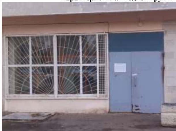
Фото 5. Общий вход с жилыми помещениями со двора
