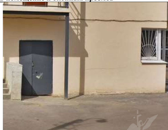
Фото 6. Общий вход с жилыми помещениями со двора
