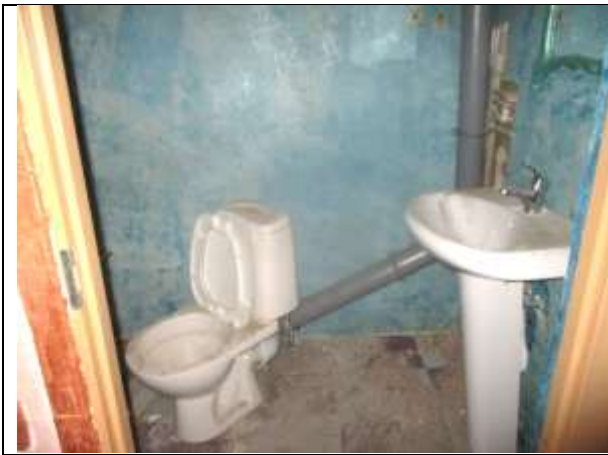
Фото 13. Внутреннее состояние Объекта оценки
