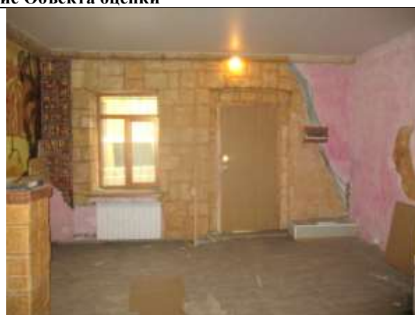
Фото 10. Внутреннее состояние Объекта оценки
