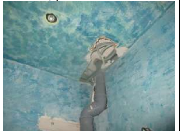
Фото 16. Внутреннее состояние Объекта оценки
