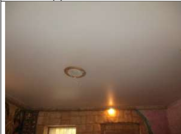
Фото 15. Внутреннее состояние Объекта оценки
