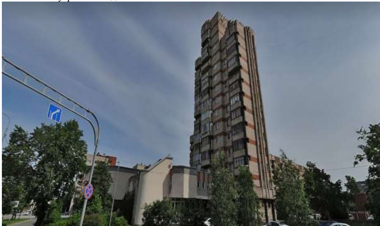
Фото 1. Вид здания, в котором расположен Объект оценки
