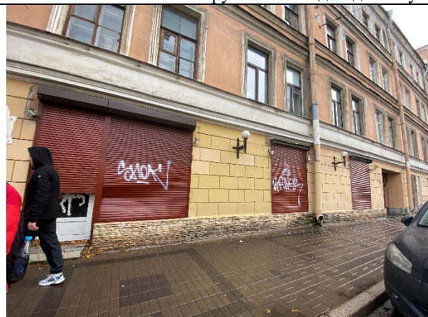
Фото № 4 – Вход в помещение с улицы
