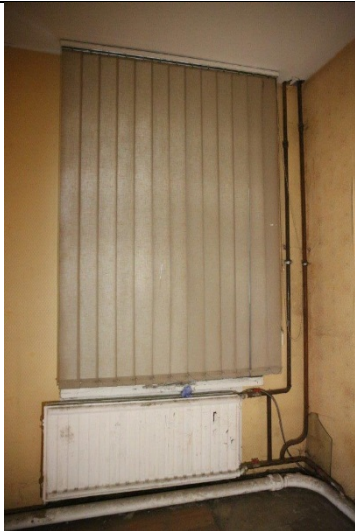
Фото № 17 – Внутреннее состояние помещения
