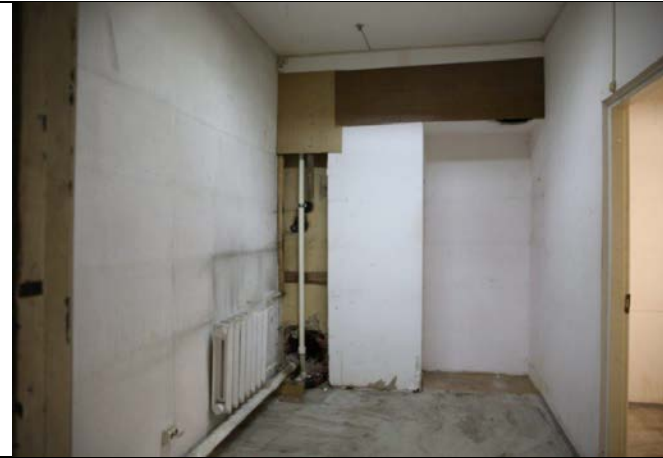
Фото № 21 – Внутреннее состояние помещения
