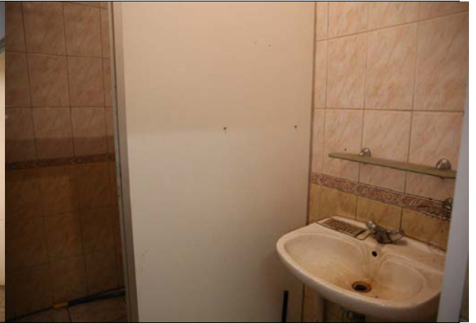
Фото № 22 – Внутреннее состояние помещения
