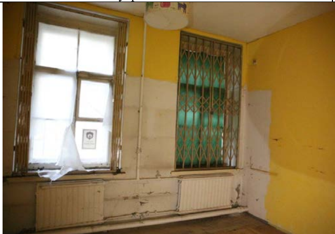
Фото № 19 – Внутреннее состояние помещения
