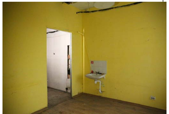
Фото № 18 – Внутреннее состояние помещения
