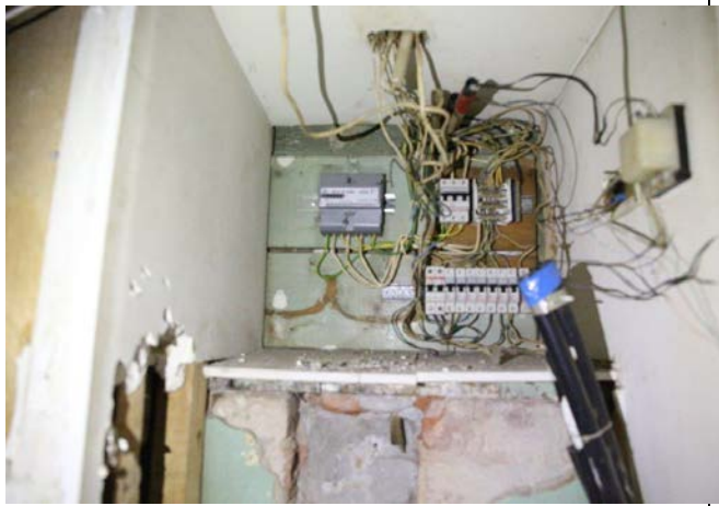
Фото № 15 – Внутреннее состояние помещения
