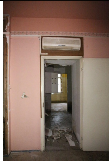
Фото № 16 – Внутреннее состояние помещения
