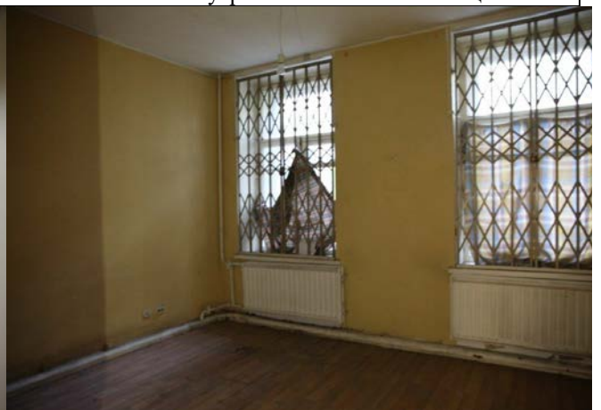
Фото № 26 – Внутреннее состояние помещения
