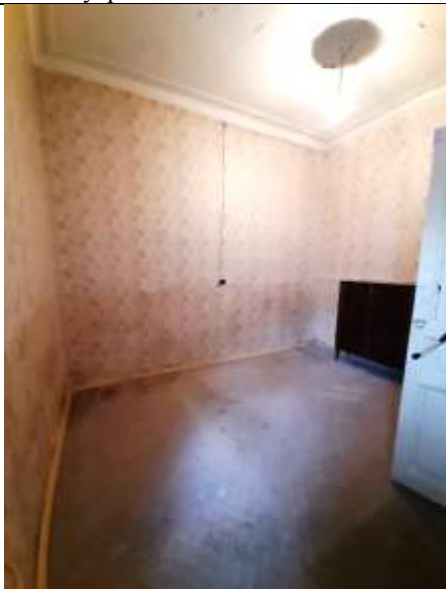
Фото 9. Внутреннее состояние Объекта оценки
