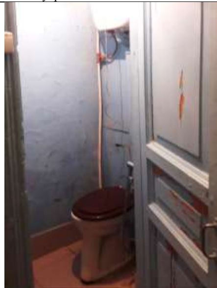
Фото 10. Внутреннее состояние Объекта оценки
