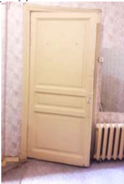
Фото 11. Внутреннее состояние Объекта оценки
