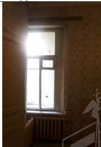
Фото 12. Внутреннее состояние Объекта оценки
