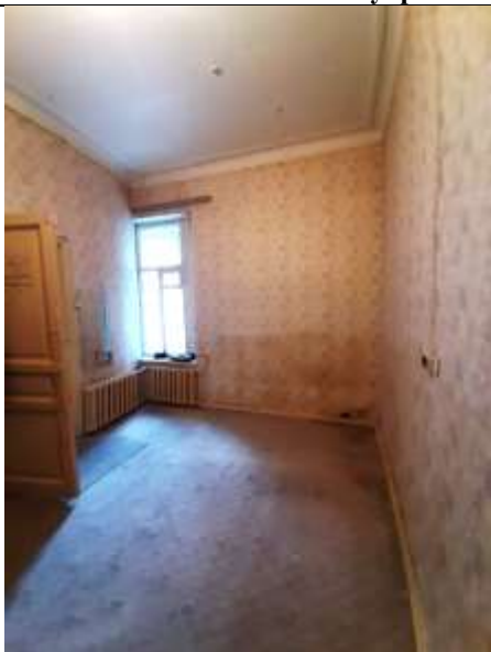
Фото 7. Внутреннее состояние Объекта оценки
