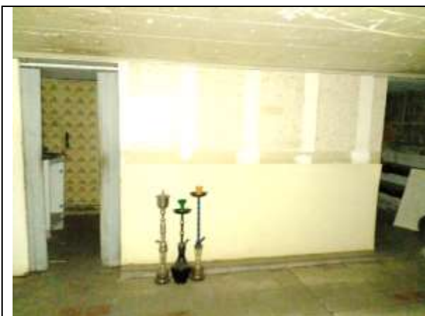
Фото 13. Внутреннее состояние Объекта оценки
