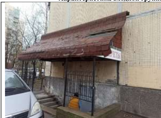
Фото 5. Отдельный вход с улицы (с торца здания)
