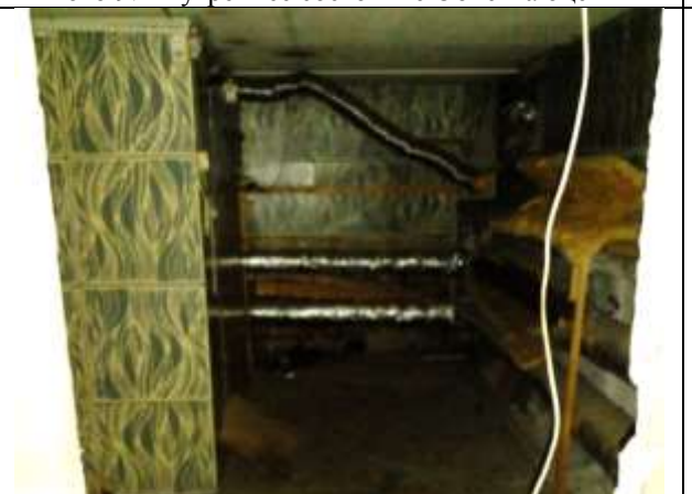
Фото 11. Внутреннее состояние Объекта оценки
