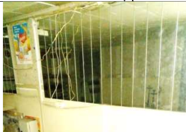
Фото 7. Внутреннее состояние Объекта оценки
