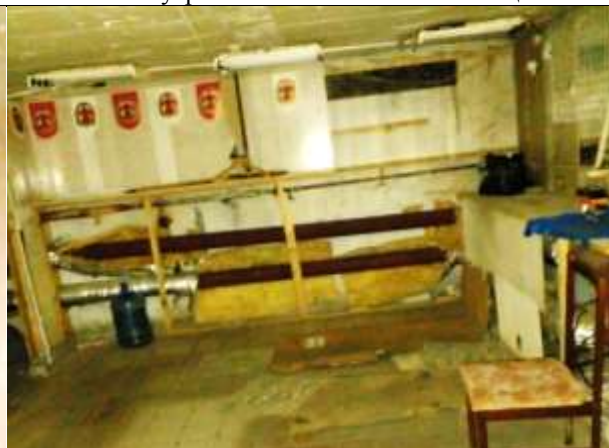
Фото 10. Внутреннее состояние Объекта оценки
