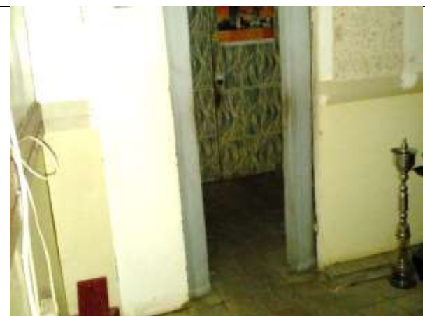
Фото 14. Внутреннее состояние Объекта оценки
