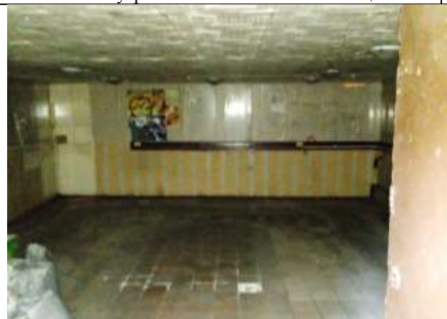
Фото 9. Внутреннее состояние Объекта оценки
