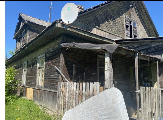
Фото 3. Вид на здание размещения Объекта оценки.
