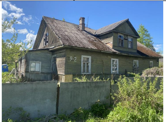
Фото 4. Вид на здание размещения Объекта оценки.
