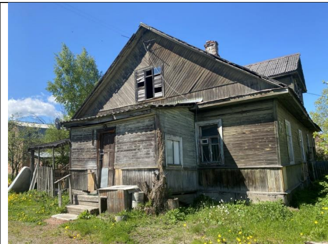
Фото 1. Вид на здание размещения Объекта оценки.
