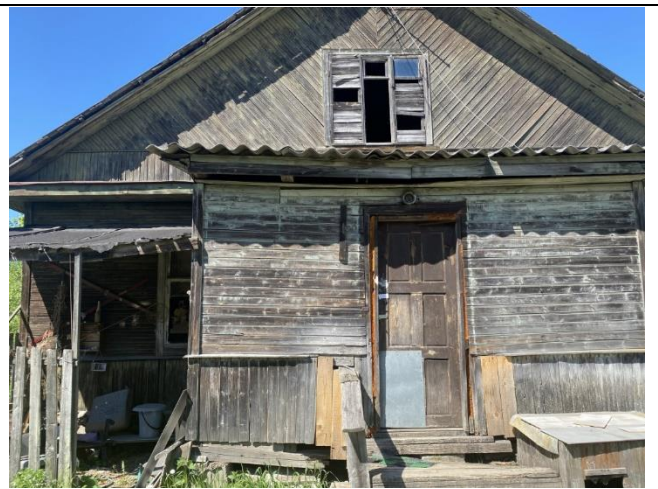
Фото 2. Вид на здание размещения Объекта оценки.
