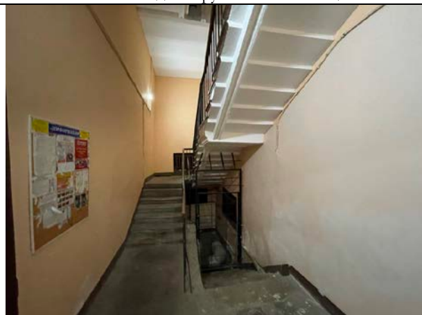
Фото 43. Лестница в подьезде объекта оценки
