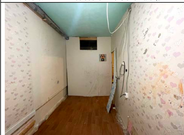
Фото 49. Типичное состояние Объекта оценки
