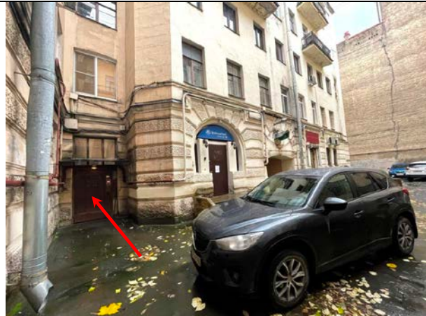
Фото 39. Вид здания расположения Объекта оценки
