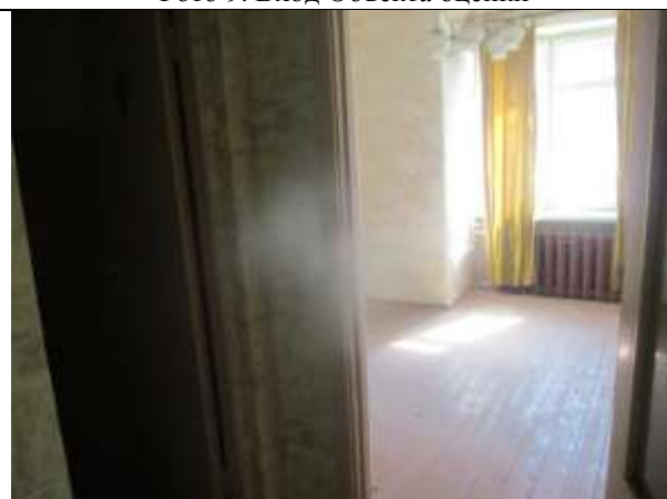
Фото 11. Внутреннее состояние Объекта оценки
