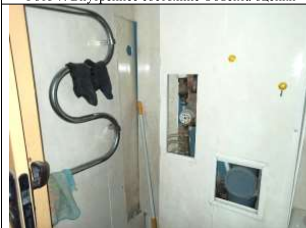
Фото 9. Внутреннее состояние Объекта оценки
