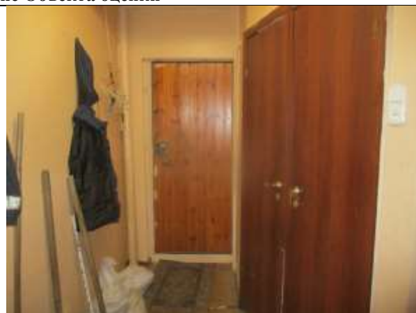
Фото 7. Внутреннее состояние Объекта оценки
