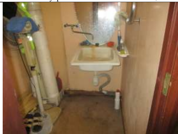
Фото 9. Внутреннее состояние Объекта оценки
