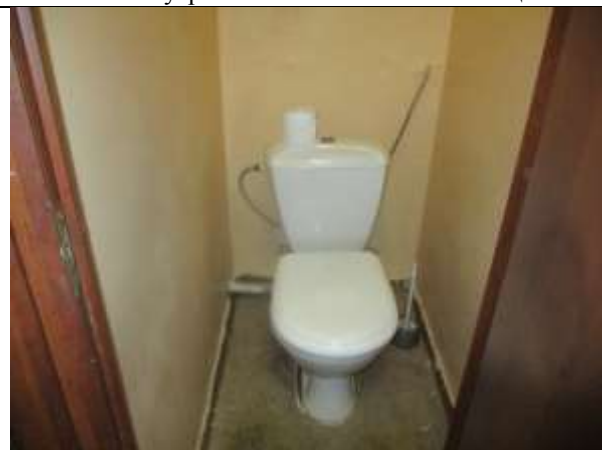
Фото 8. Внутреннее состояние Объекта оценки
