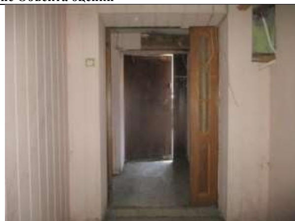
Фото 14. Внутреннее состояние Объекта оценки
