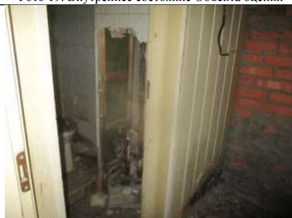
Фото 21. Внутреннее состояние Объекта оценки
