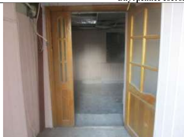
Фото 13. Внутреннее состояние Объекта оценки
