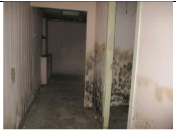
Фото 16. Внутреннее состояние Объекта оценки
