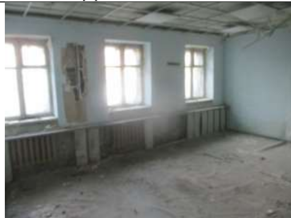
Фото 17. Внутреннее состояние Объекта оценки
