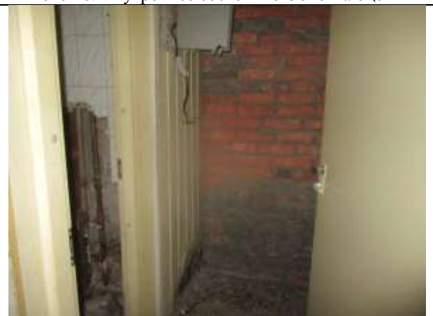
Фото 20. Внутреннее состояние Объекта оценки
