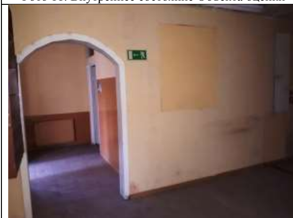
Фото 13. Внутреннее состояние Объекта оценки
