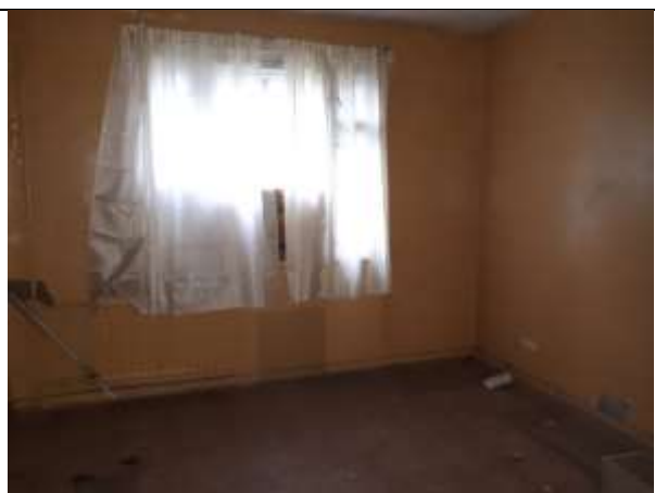
Фото 20. Внутреннее состояние Объекта оценки
