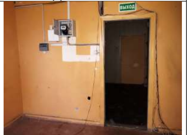
Фото 14. Внутреннее состояние Объекта оценки
