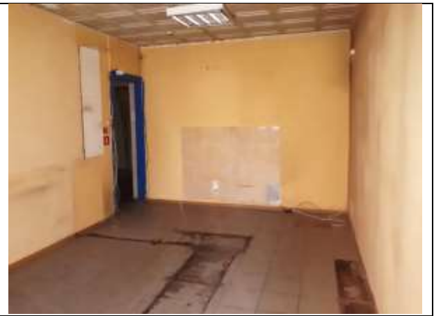
Фото 12. Внутреннее состояние Объекта оценки
