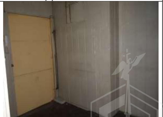
Фото 18. Внутреннее состояние Объекта оценки
