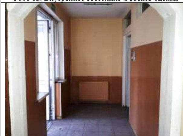
Фото 15. Внутреннее состояние Объекта оценки
