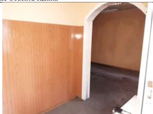
Фото 10. Внутреннее состояние Объекта оценки
