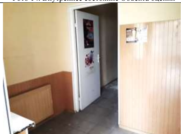
Фото 16. Внутреннее состояние Объекта оценки
