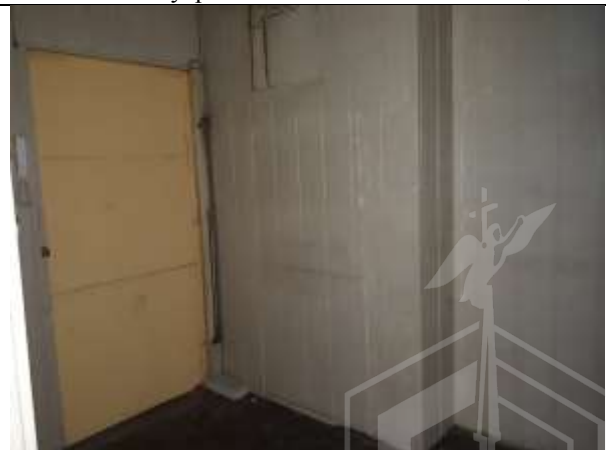
Фото 18. Внутреннее состояние Объекта оценки
