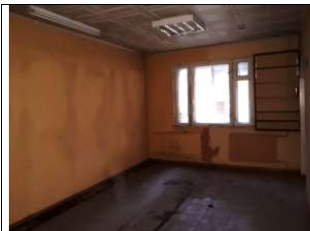
Фото 11. Внутреннее состояние Объекта оценки
