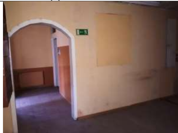
Фото 13. Внутреннее состояние Объекта оценки
