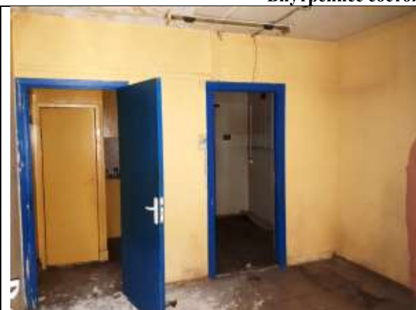
Фото 9. Внутреннее состояние Объекта оценки
