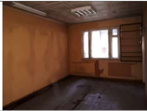
Фото 11. Внутреннее состояние Объекта оценки
