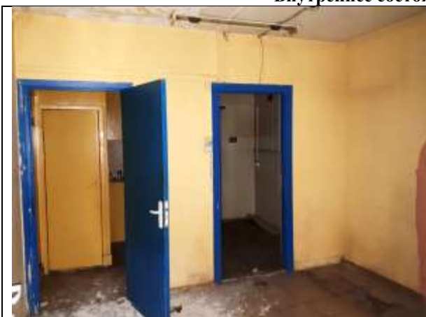
Фото 9. Внутреннее состояние Объекта оценки
