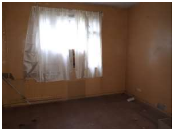
Фото 20. Внутреннее состояние Объекта оценки
