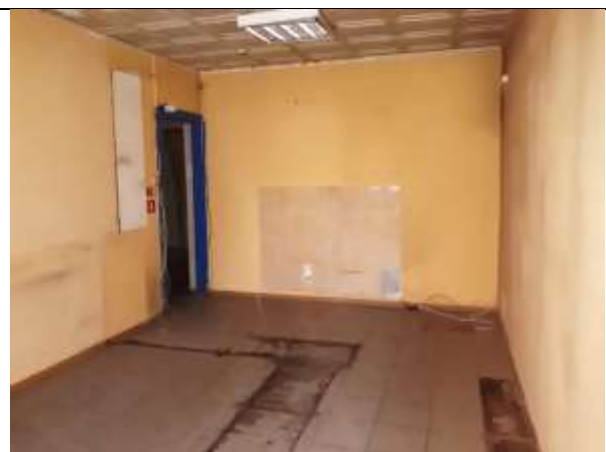
Фото 12. Внутреннее состояние Объекта оценки
