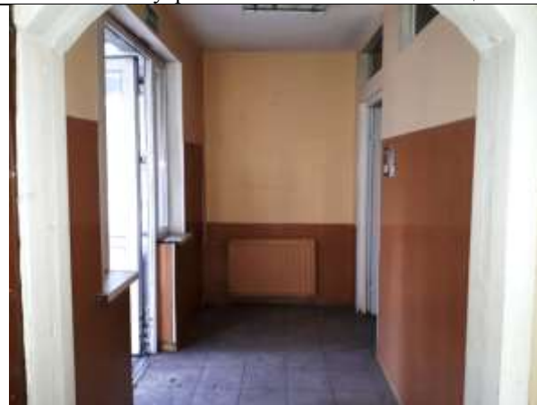
Фото 15. Внутреннее состояние Объекта оценки
