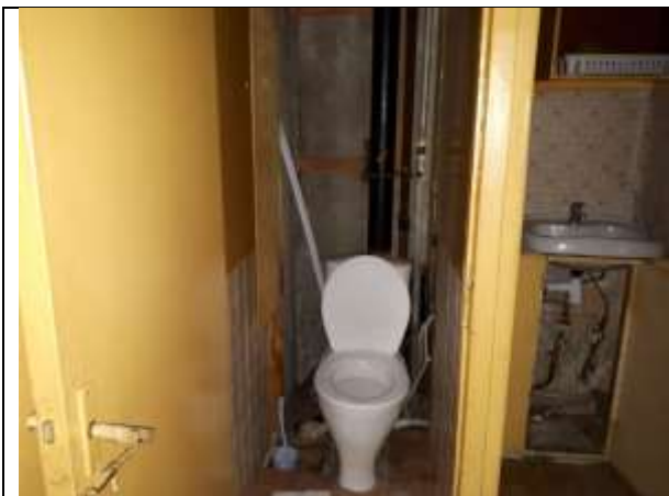
Фото 19. Внутреннее состояние Объекта оценки
