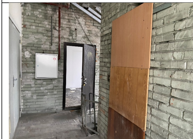
Фото № 7 – Вход в помещение
