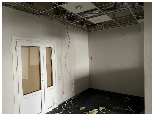
Фото № 8 – Внутреннее состояние помещения
