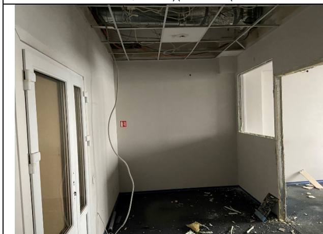
Фото № 9 – Внутреннее состояние помещения
