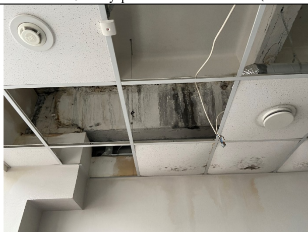
Фото № 10 – Внутреннее состояние помещения
