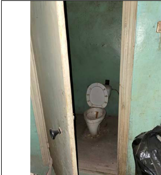
Фото № 13 – Внутреннее состояние помещения
