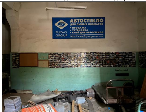
Фото № 10 – Внутреннее состояние помещения
