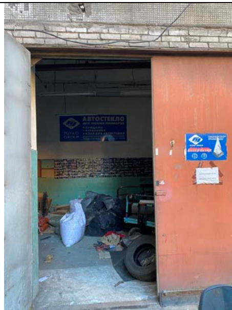
Фото № 8 – Вход в помещение со двора
