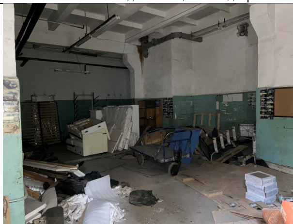
Фото № 9 – Внутреннее состояние помещения
