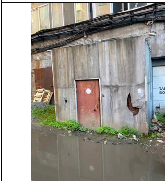
Фото № 7 – Вход в помещение со двора
