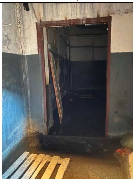
Фото № 8 – Вход в помещение со двора
