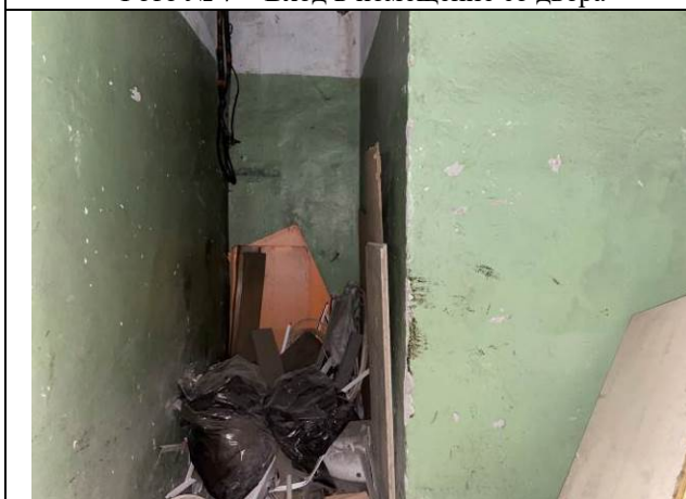
Фото № 9 – Внутреннее состояние помещения
