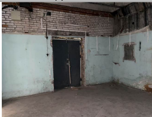
Фото № 16 – Внутреннее состояние помещения
