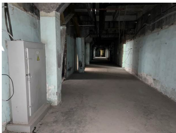
Фото № 17 – Внутреннее состояние помещения
