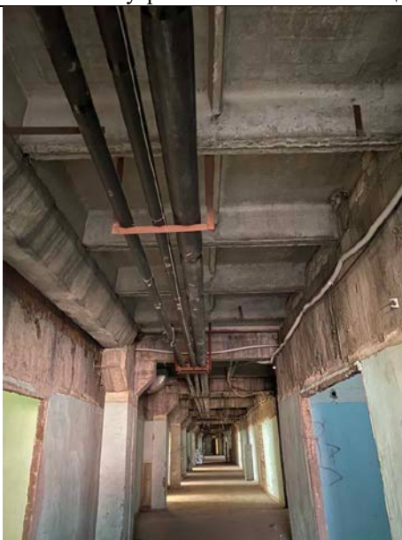
Фото № 25 – Внутреннее состояние помещения
