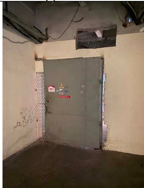
Фото № 24 – Внутреннее состояние помещения
