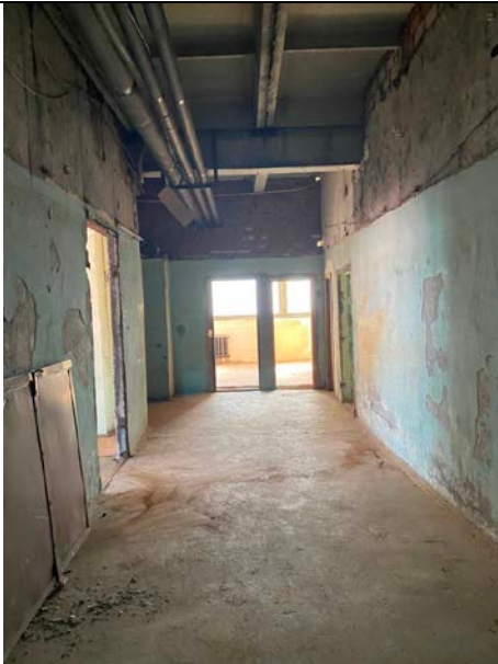
Фото № 21 – Внутреннее состояние помещения
