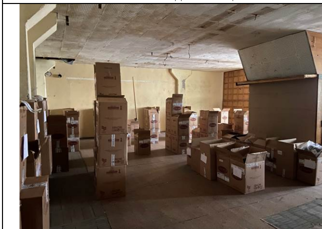
Фото № 9 – Внутреннее состояние помещения
