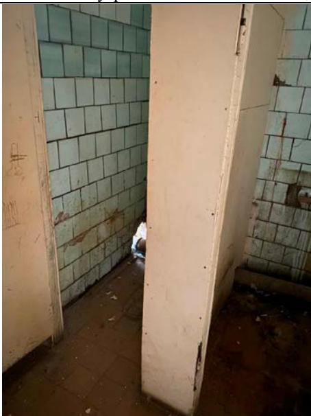
Фото № 23 – Внутреннее состояние помещения
