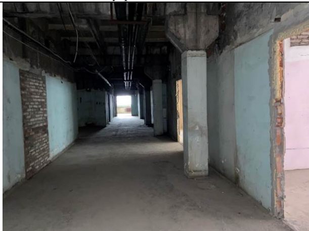
Фото № 15 – Внутреннее состояние помещения
