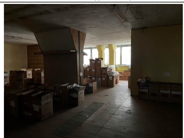
Фото № 10 – Внутреннее состояние помещения
