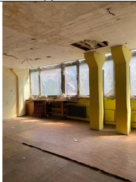
Фото № 18 – Внутреннее состояние помещения
