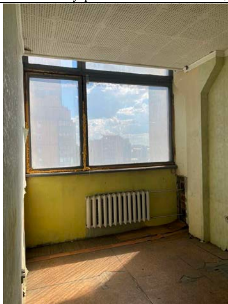
Фото № 19 – Внутреннее состояние помещения
