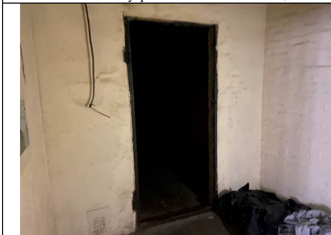
Фото № 11 – Внутреннее состояние помещения
