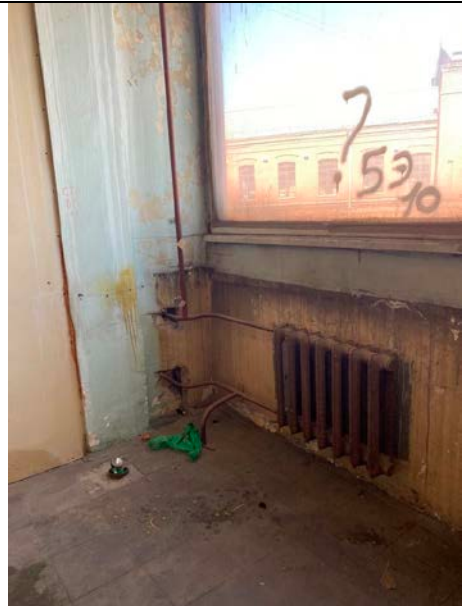
Фото № 22 – Внутреннее состояние помещения
