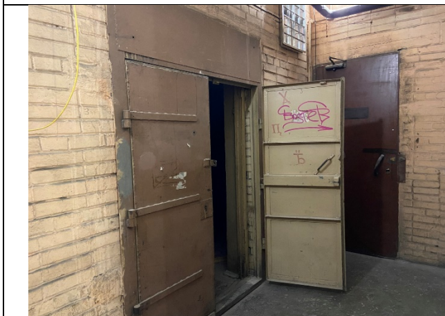
Фото № 7 – Внутреннее состояние помещения
