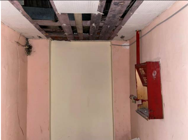
Фото № 21 – Внутреннее состояние помещения
