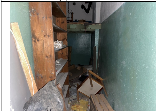
Фото № 9 – Внутреннее состояние помещения
