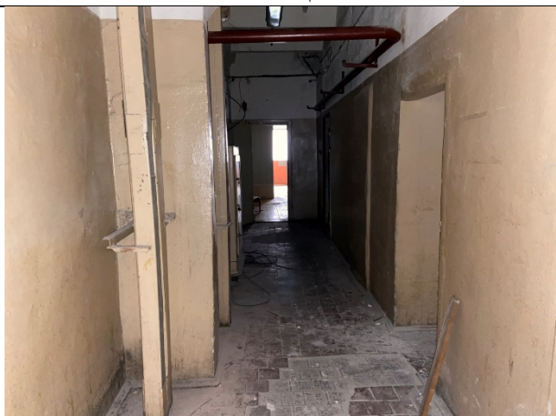
Фото № 8 – Внутреннее состояние помещения
