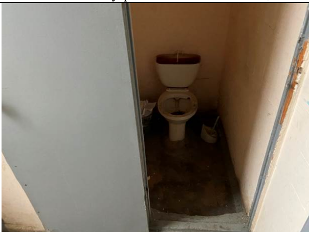
Фото № 15 – Внутреннее состояние помещения
