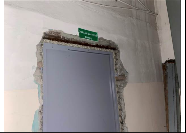
Фото № 18 – Внутреннее состояние помещения
