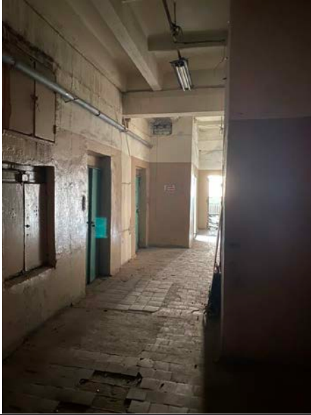
Фото № 19 – Внутреннее состояние помещения
