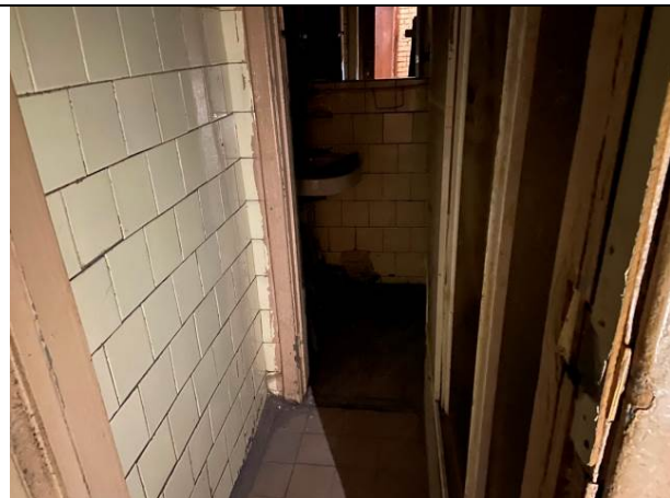
Фото № 24 – Внутреннее состояние помещения
