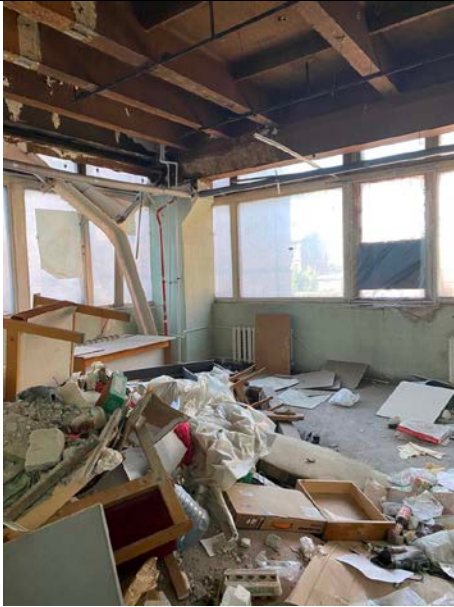
Фото № 11 – Внутреннее состояние помещения
