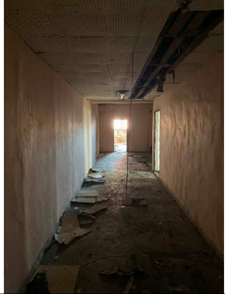
Фото № 20 – Внутреннее состояние помещения
