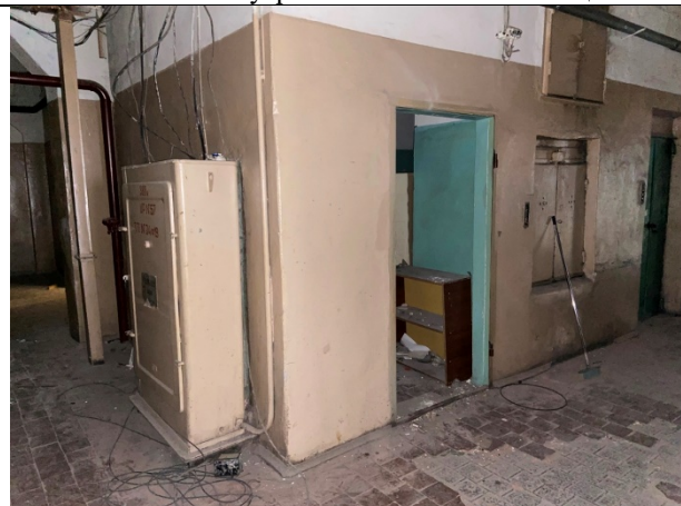
Фото № 26 – Внутреннее состояние помещения
