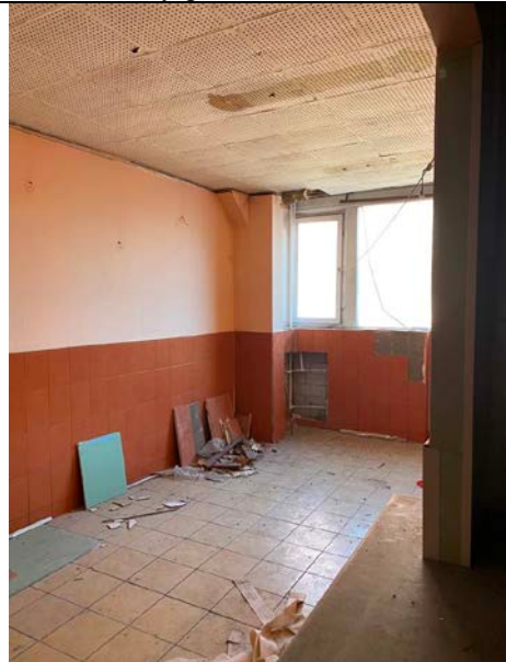
Фото № 14 – Внутреннее состояние помещения
