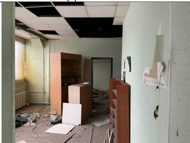
Фото № 10 – Внутреннее состояние помещения
