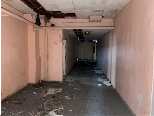
Фото № 17 – Внутреннее состояние помещения
