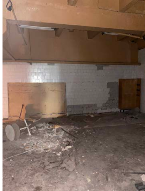
Фото № 12 – Внутреннее состояние помещения
