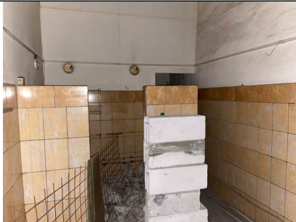
Фото № 11 – Внутреннее состояние помещения 3-Н
