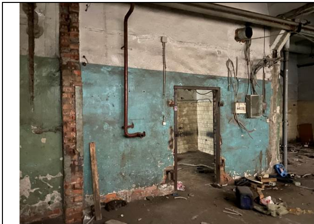
Фото № 13 – Внутреннее состояние помещения 5-Н
