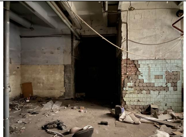
Фото № 16 – Внутреннее состояние помещения 5-Н
