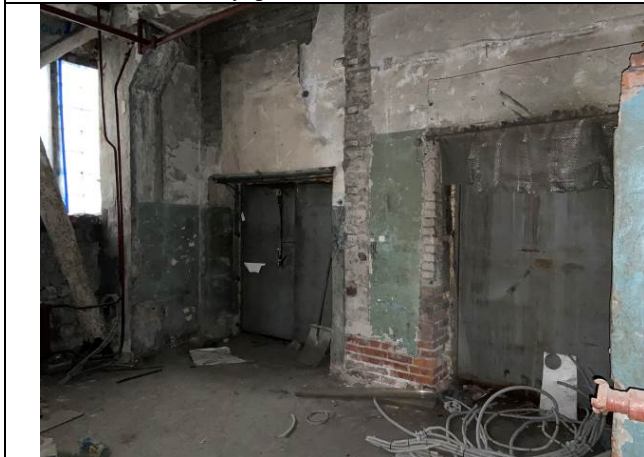
Фото № 15 – Внутреннее состояние помещения 5-Н
