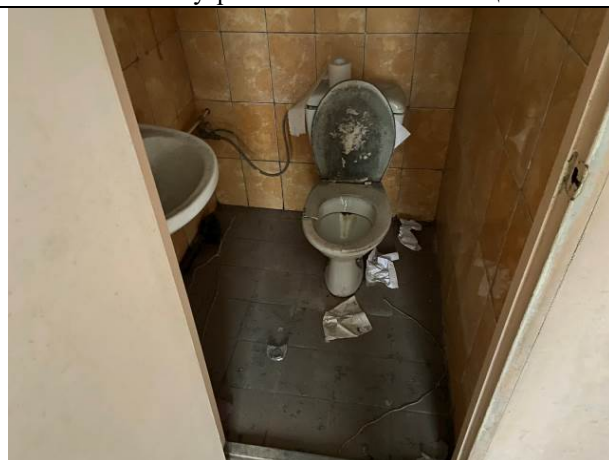
Фото № 10 – Внутреннее состояние помещения 3-Н
