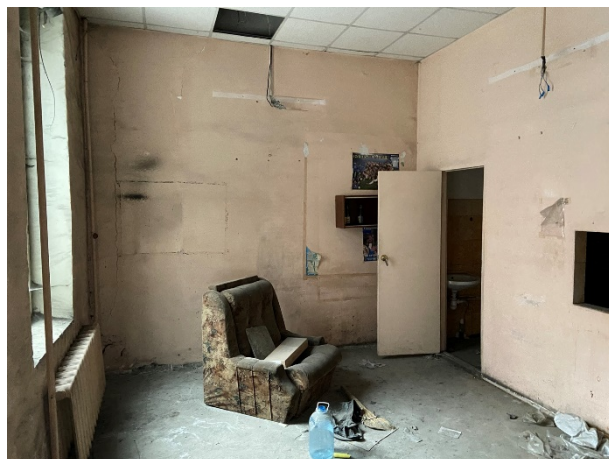
Фото № 8 – Внутреннее состояние помещения 3-Н
