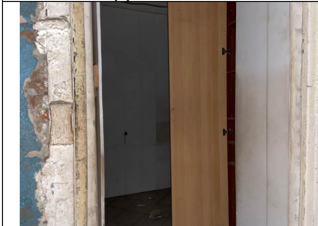
Фото № 19 – Внутреннее состояние помещения 5-Н
