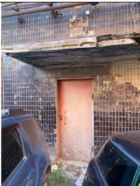
Фото № 7 – Вход в помещение 3-Н
