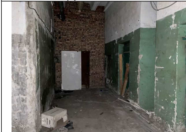
Фото № 17 – Внутреннее состояние помещения 5-Н
