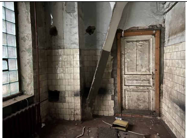
Фото № 14 – Внутреннее состояние помещения 5-Н
