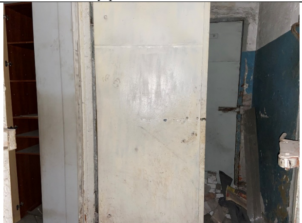
Фото № 18 – Внутреннее состояние помещения 5-Н
