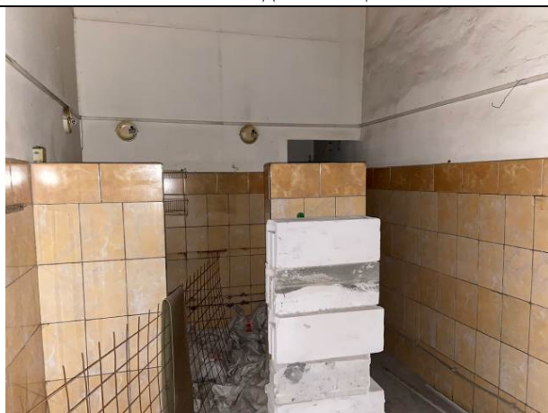
Фото № 9 – Внутреннее состояние помещения 3-Н
