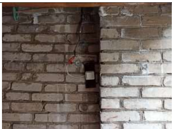
Фото 14. Внутреннее состояние Объекта оценки
