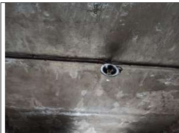
Фото 13. Внутреннее состояние Объекта оценки
