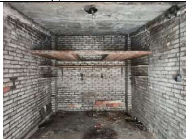
Фото 11. Внутреннее состояние Объекта оценки
