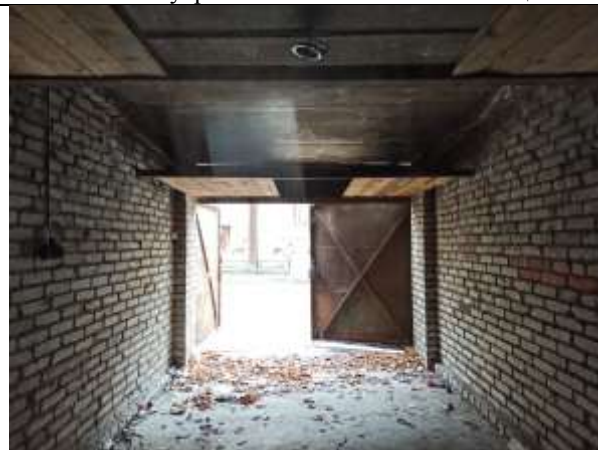
Фото 12. Внутреннее состояние Объекта оценки
