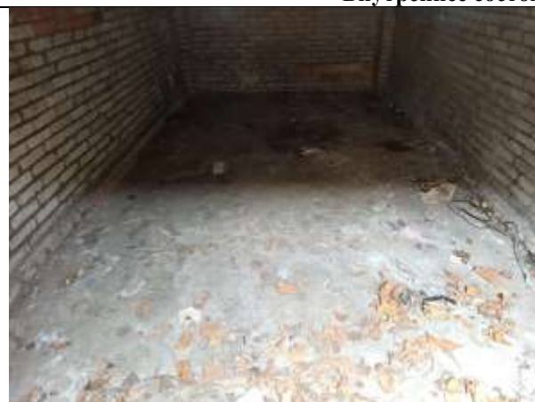
Фото 9. Внутреннее состояние Объекта оценки
