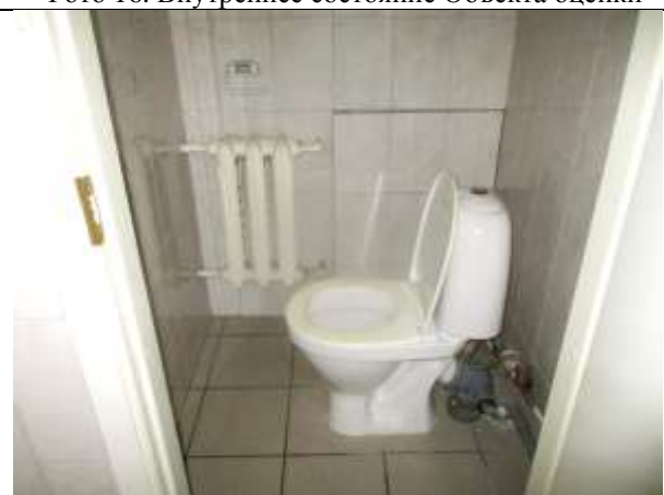
Фото 18. Внутреннее состояние Объекта оценки
