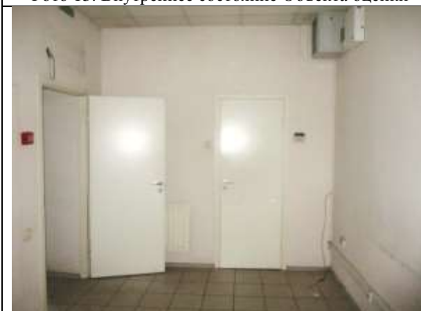
Фото 15. Внутреннее состояние Объекта оценки
