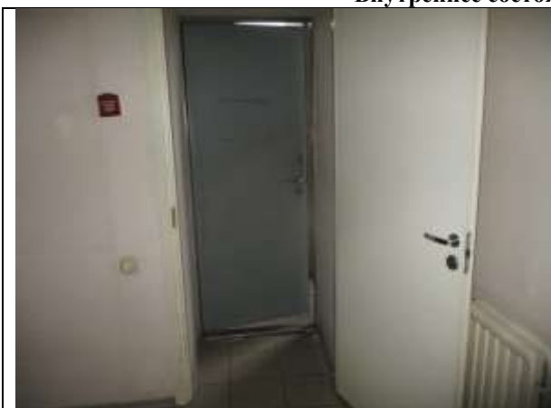
Фото 11. Внутреннее состояние Объекта оценки
