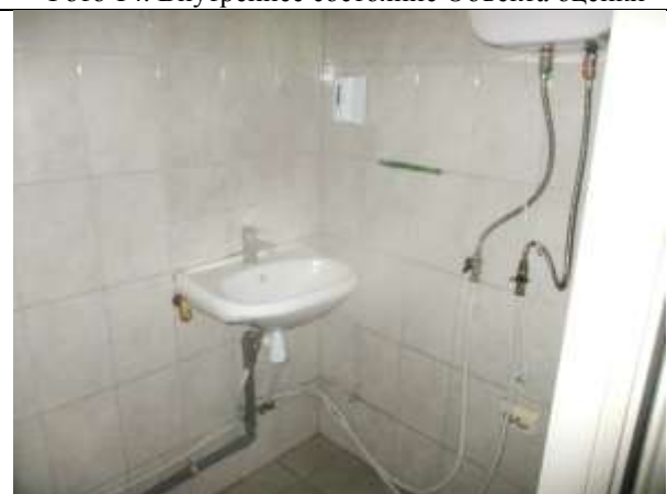
Фото 16. Внутреннее состояние Объекта оценки
