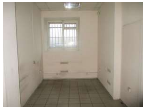
Фото 14. Внутреннее состояние Объекта оценки
