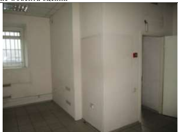
Фото 12. Внутреннее состояние Объекта оценки
