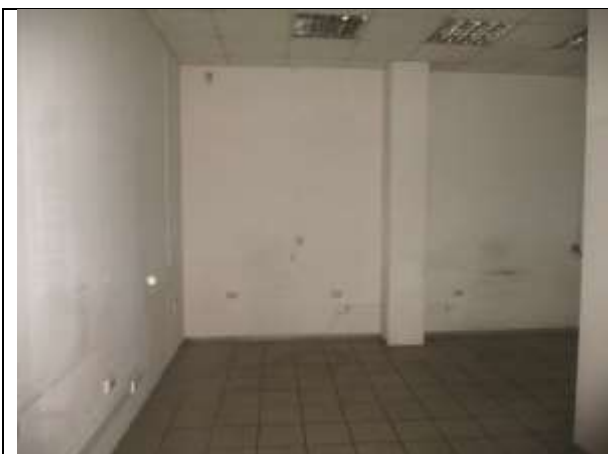
Фото 13. Внутреннее состояние Объекта оценки
