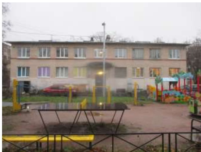
Фото 5. Ближайшее окружение. Дворовая территория Характеристика входной группы в помещение и оконных проемов
