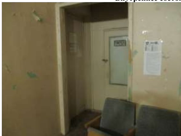
Фото 10. Вход в помещение
