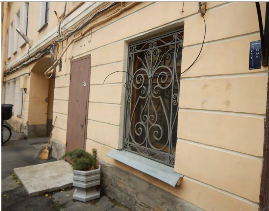
Описание: Вход на Объект
