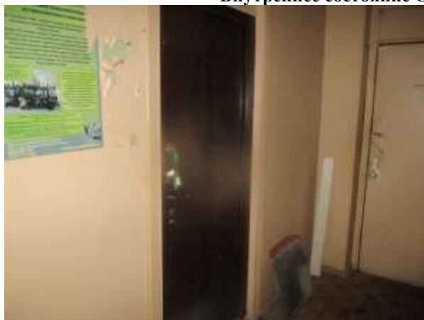
Фото 16. Вход в помещение 14-Н
