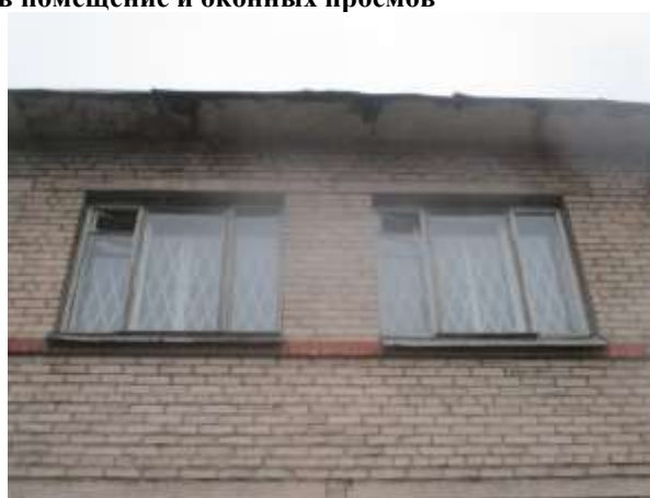
Фото 7. Оконные проемы пом. 13-Н
