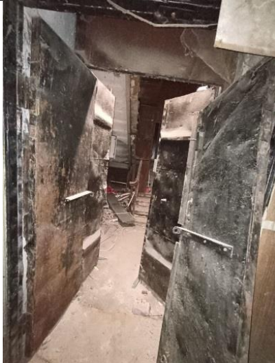
Фото № 15 – Внутреннее состояние
