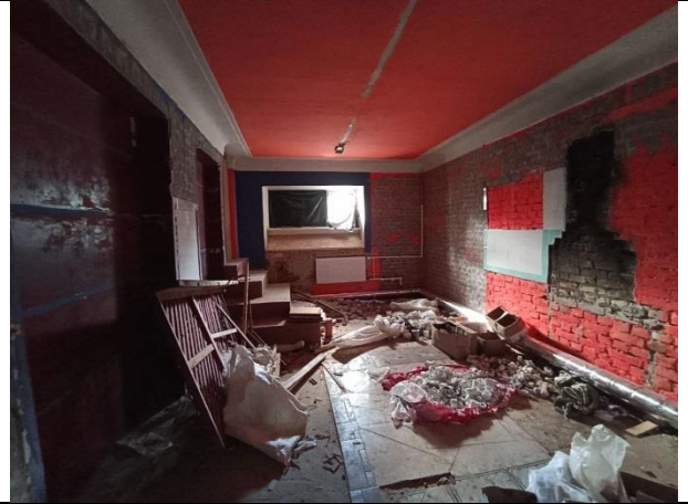
Фото № 14 – Внутреннее состояние
