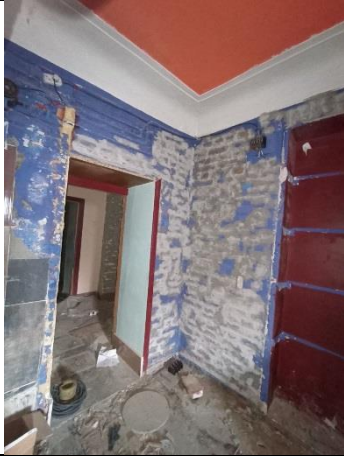
Фото № 13 – Внутреннее состояние
