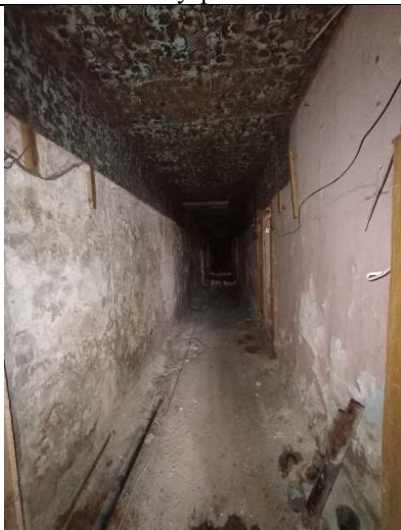
Фото № 11 – Внутреннее состояние
