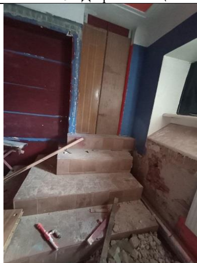
Фото № 10 – Внутреннее состояние
