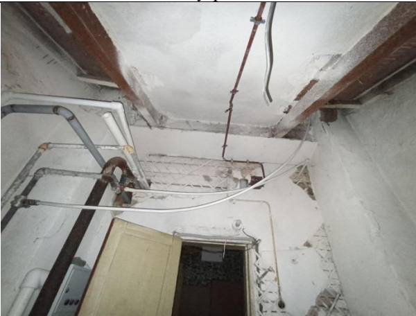
Фото № 17 – Внутреннее состояние
