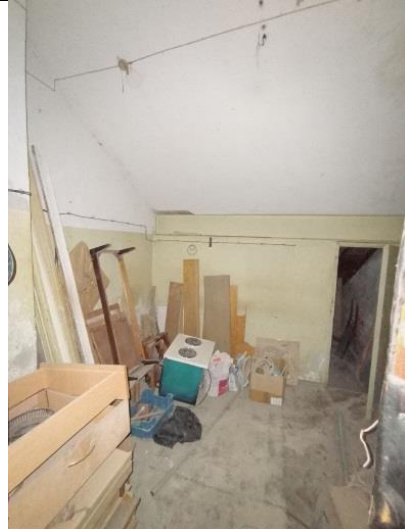
Фото № 16 – Внутреннее состояние
