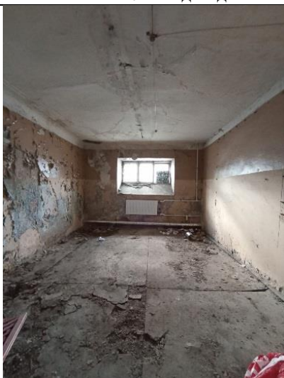
Фото № 9 – Внутреннее состояние
