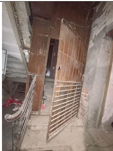
Фото № 8 – Дверь в помещении
