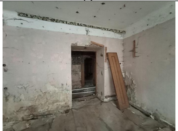
Фото № 18 – Внутреннее состояние
