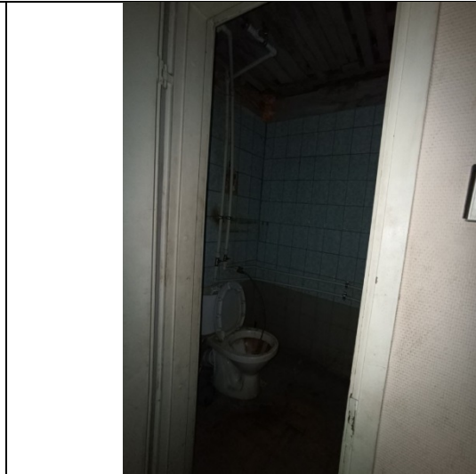
Фото № 18 – Внутреннее состояние помещения
