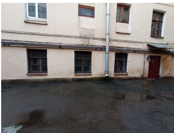
Фото № 7 – Расположение окон (со двора)
