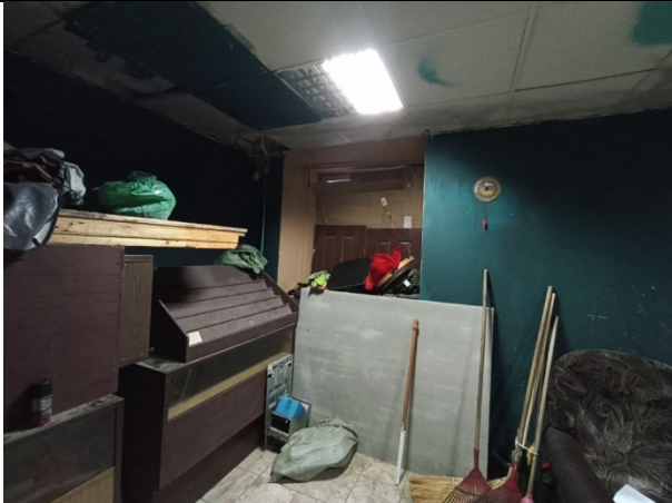
Фото № 15 – Внутреннее состояние помещения
