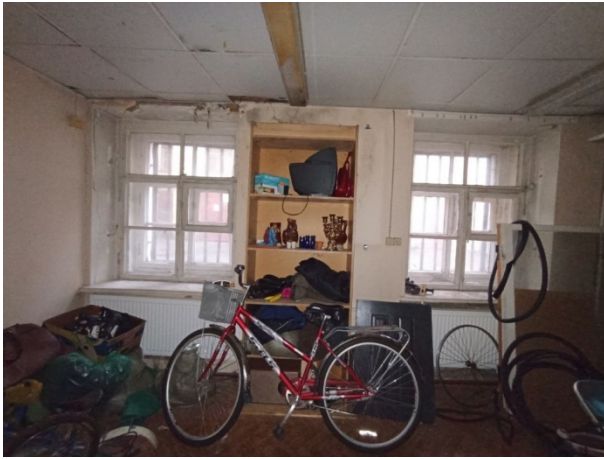
Фото № 11 – Внутреннее состояние помещения
