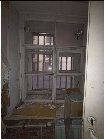
Фото № 13 – Внутреннее состояние помещения
