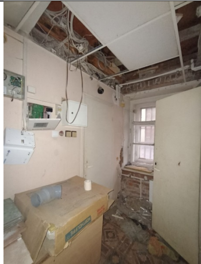
Фото № 14 – Внутреннее состояние помещения
