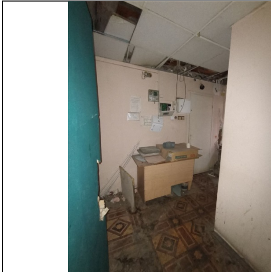
Фото № 17 – Внутреннее состояние помещения
