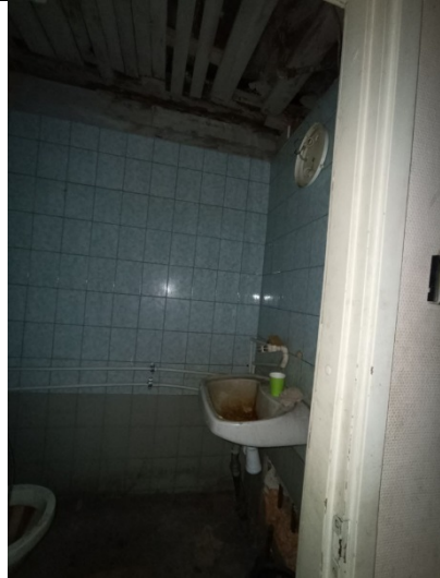
Фото № 12 – Внутреннее состояние помещения
