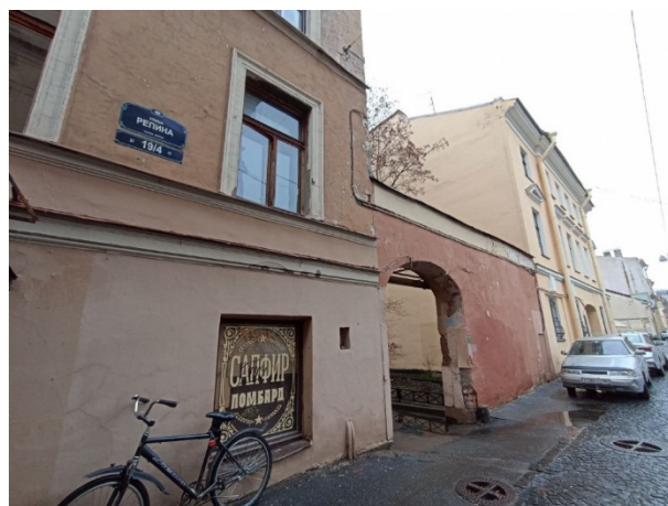
Фото № 2 – Ближайшее окружение и подъездные пути
