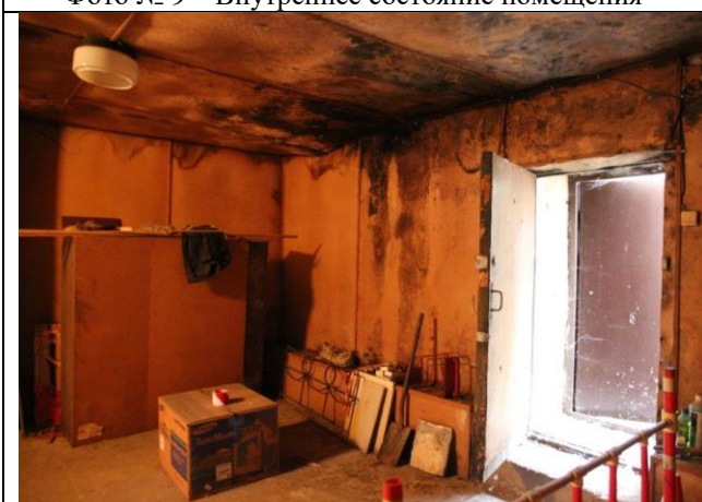
Фото № 11 – Внутреннее состояние помещения
