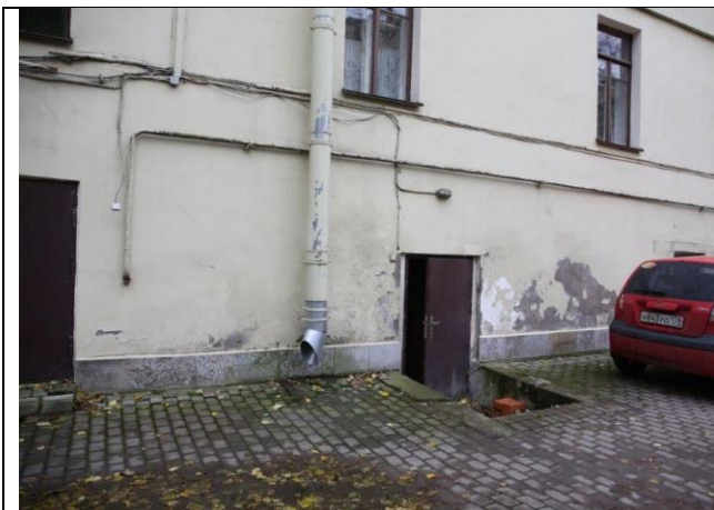
Фото № 7 – Вход в помещение со двора
