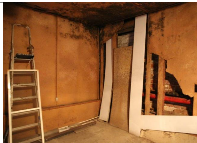
Фото № 8 – Внутреннее состояние помещения
