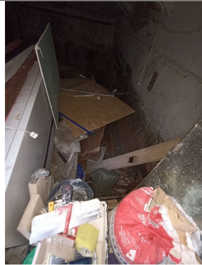
Фото № 8 – Внутреннее состояние помещения
