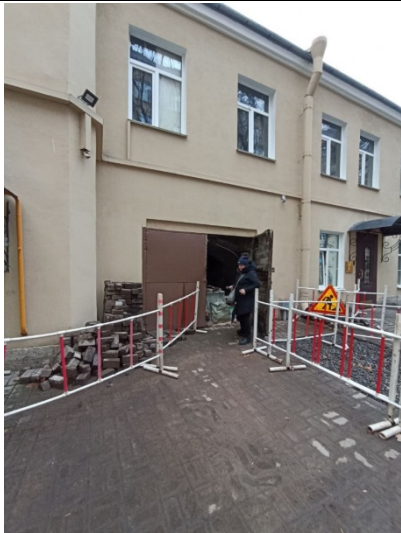
Фото № 5 – Вход в помещение
