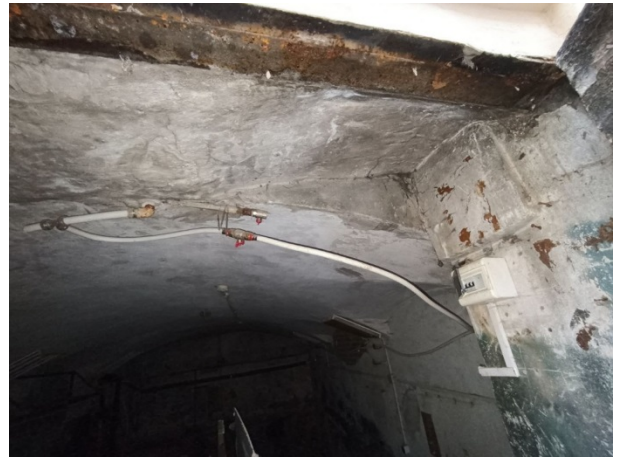
Фото № 6 – Внутреннее состояние помещения
