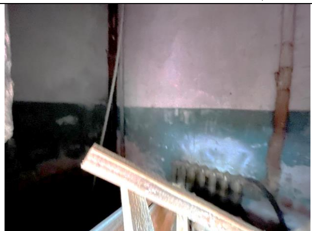
Фото 24. Типичное состояние Объекта оценки
