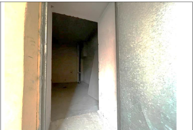
Фото 24. Типичное состояние Объекта оценки
