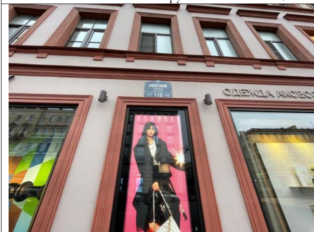
Фото 15. Адрес Объекта оценки (табличка здания, в котором расположен Объект оценки)
