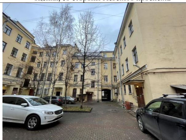
Фото 20. Внутри дворовая территория здания, в котором расположен Объект оценки
