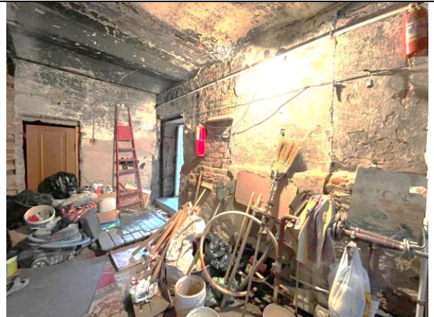
Фото 26. Типичное состояние Объекта оценки
