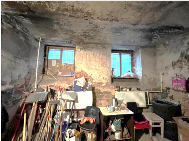
Фото 27. Типичное состояние Объекта оценки
