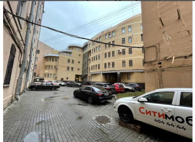
Фото 18. Внутри дворовая территория здания, в котором расположен Объект оценки
