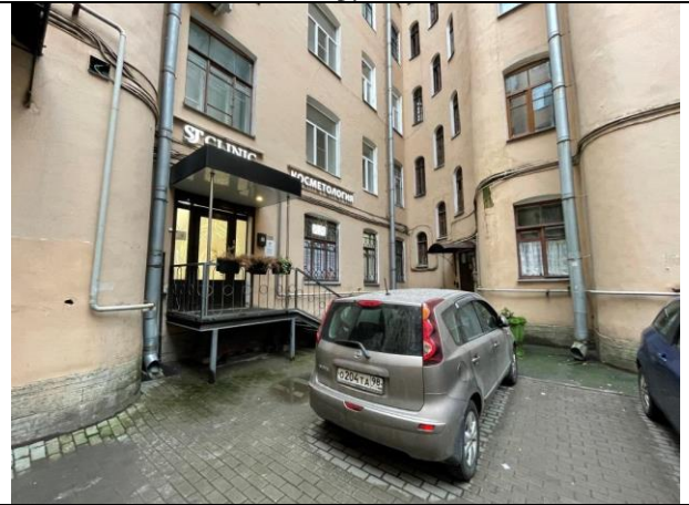
Фото 16. Вид здания, в котором расположен Объект оценки (дворовая территория)
