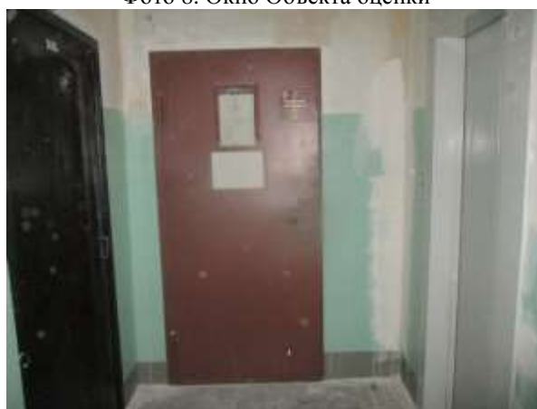
Фото 10. Вход Объекта оценки
