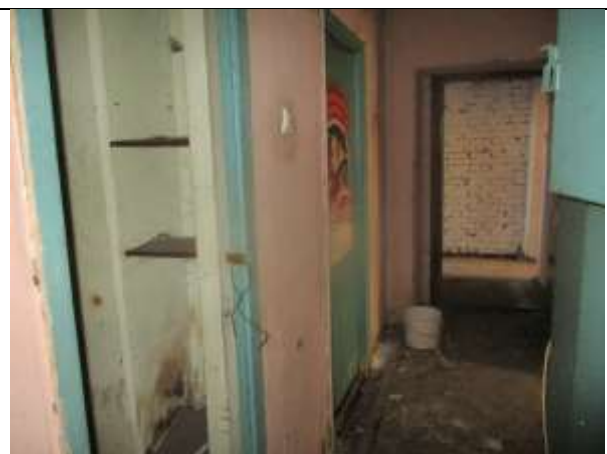
Фото 42. Внутреннее состояние Объекта оценки
