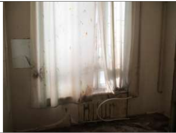
Фото 33. Внутреннее состояние Объекта оценки
