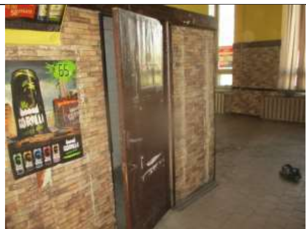
Фото 18. Внутреннее состояние Объекта оценки
