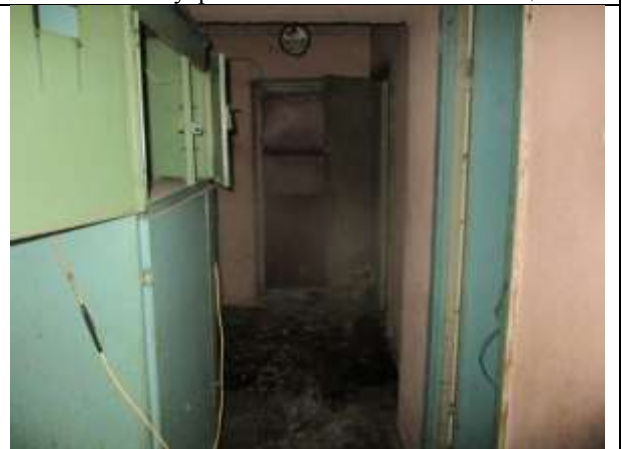
Фото 38. Внутреннее состояние Объекта оценки
