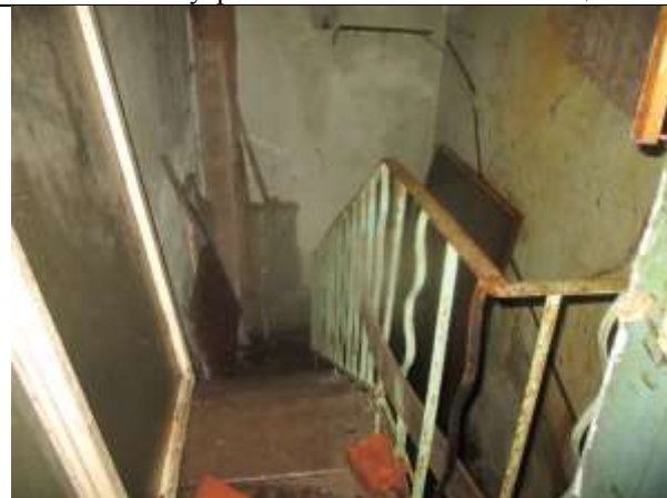
Фото 37. Выход в подвал из пом. 5-Н
