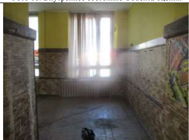
Фото 20. Внутреннее состояние Объекта оценки
