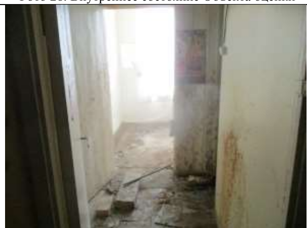
Фото 28. Внутреннее состояние Объекта оценки
