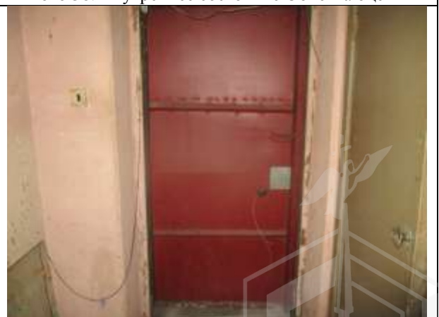
Фото 40. Внутреннее состояние Объекта оценки
