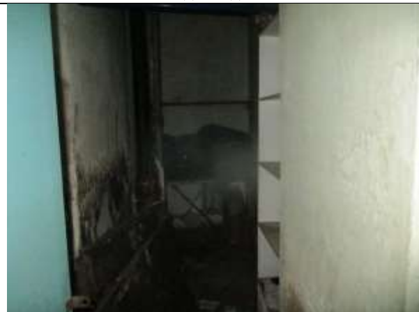
Фото 39. Внутреннее состояние Объекта оценки
