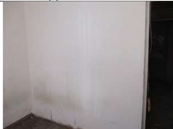
Фото 35. Внутреннее состояние Объекта оценки
