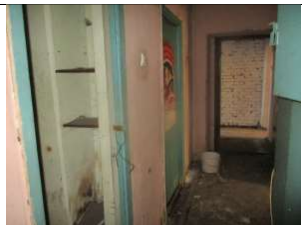
Фото 42. Внутреннее состояние Объекта оценки
