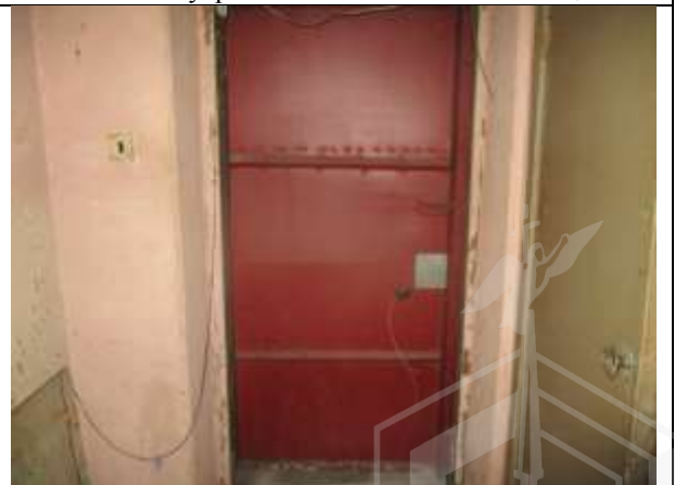
Фото 40. Внутреннее состояние Объекта оценки
