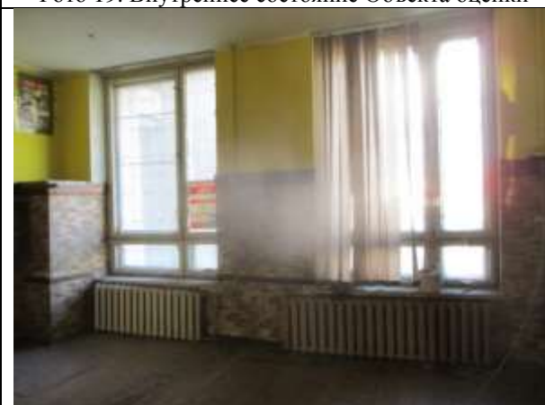
Фото 21. Внутреннее состояние Объекта оценки
