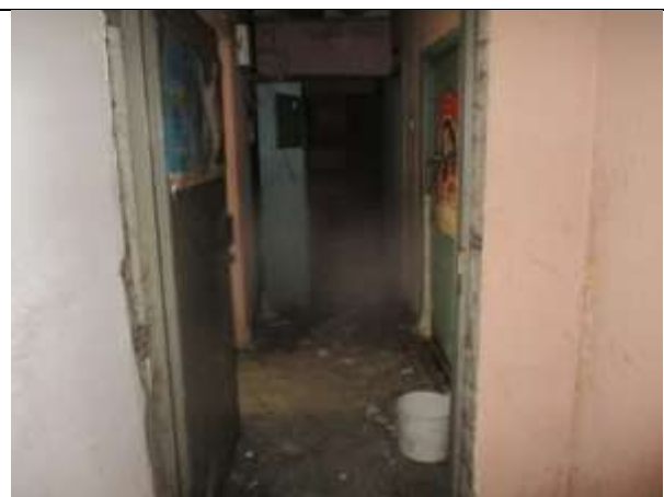
Фото 26. Внутреннее состояние Объекта оценки
