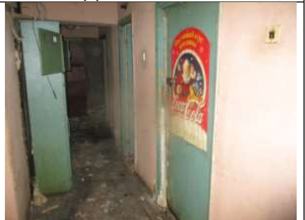
Фото 36. Внутреннее состояние Объекта оценки
