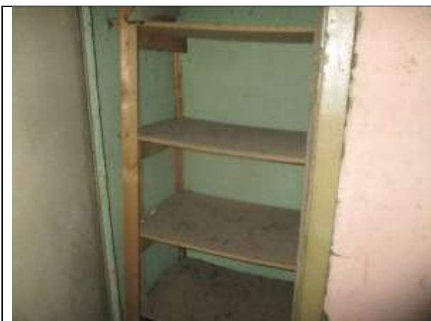
Фото 41. Внутреннее состояние Объекта оценки
