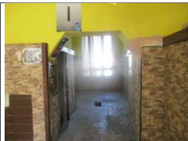
Фото 17. Внутреннее состояние Объекта оценки
