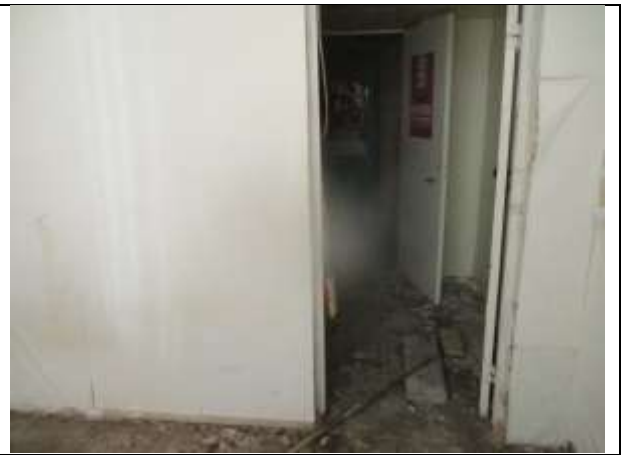
Фото 34. Внутреннее состояние Объекта оценки
