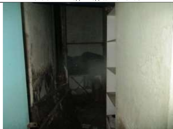
Фото 39. Внутреннее состояние Объекта оценки
