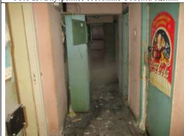
Фото 27. Внутреннее состояние Объекта оценки
