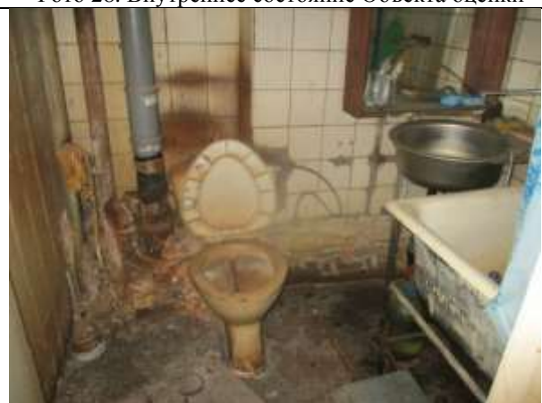
Фото 30. Внутреннее состояние Объекта оценки
