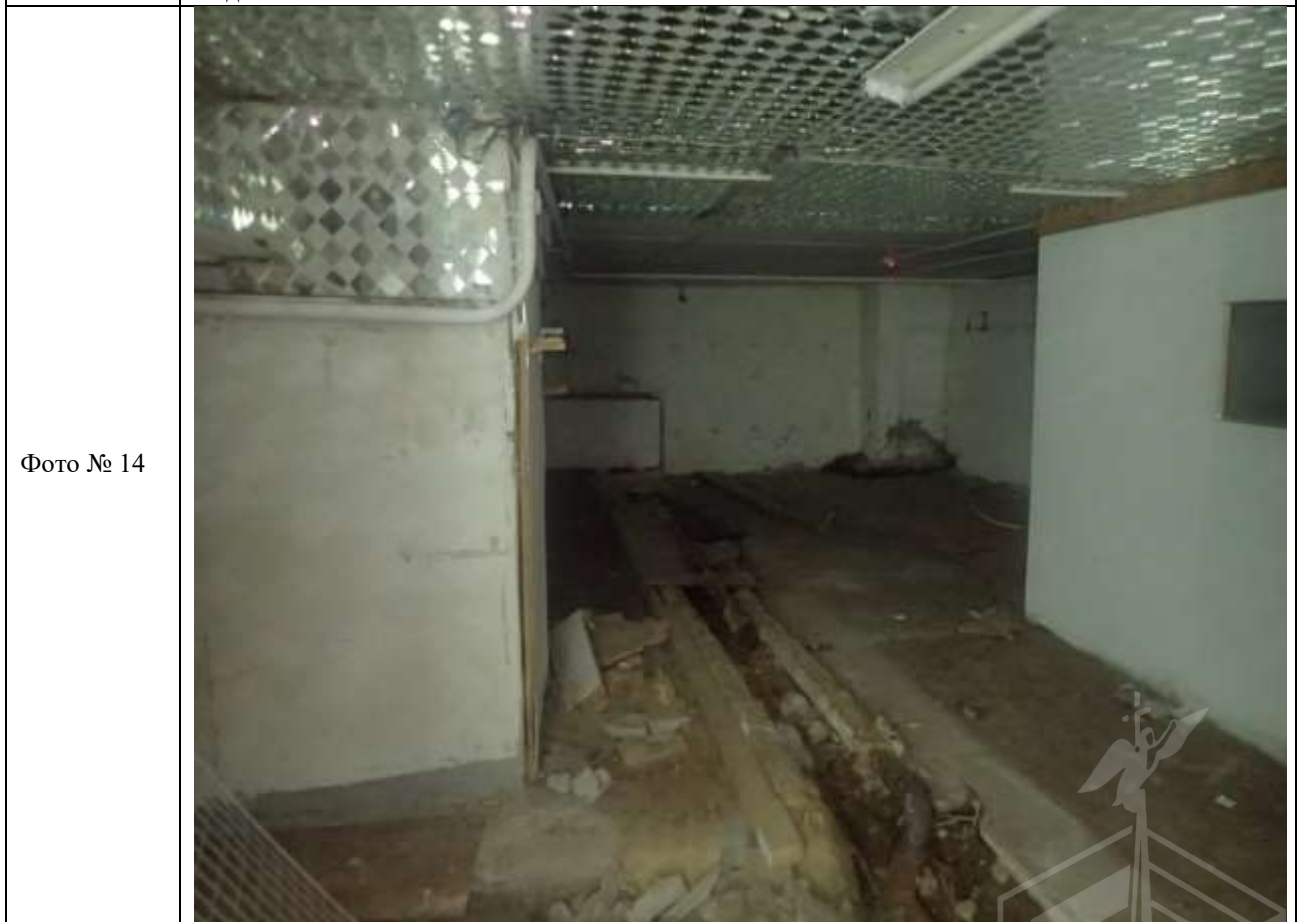
Описание: Вид ч.п. 32 Объекта
