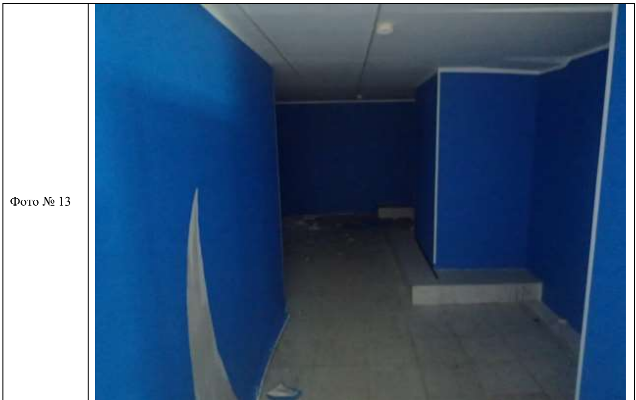
Описание: Вид ч.п. 28 Объекта
