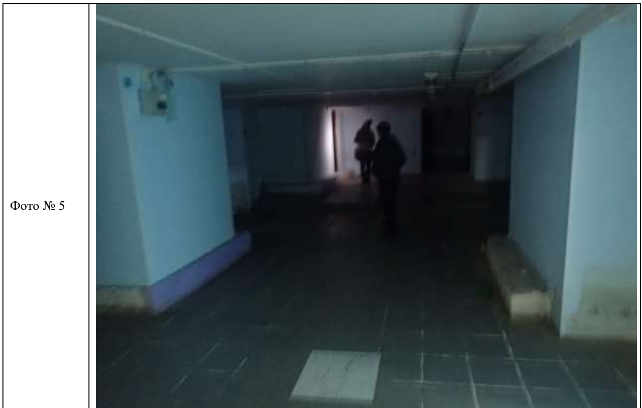
Описание: Вид ч.п. 8 Объекта
