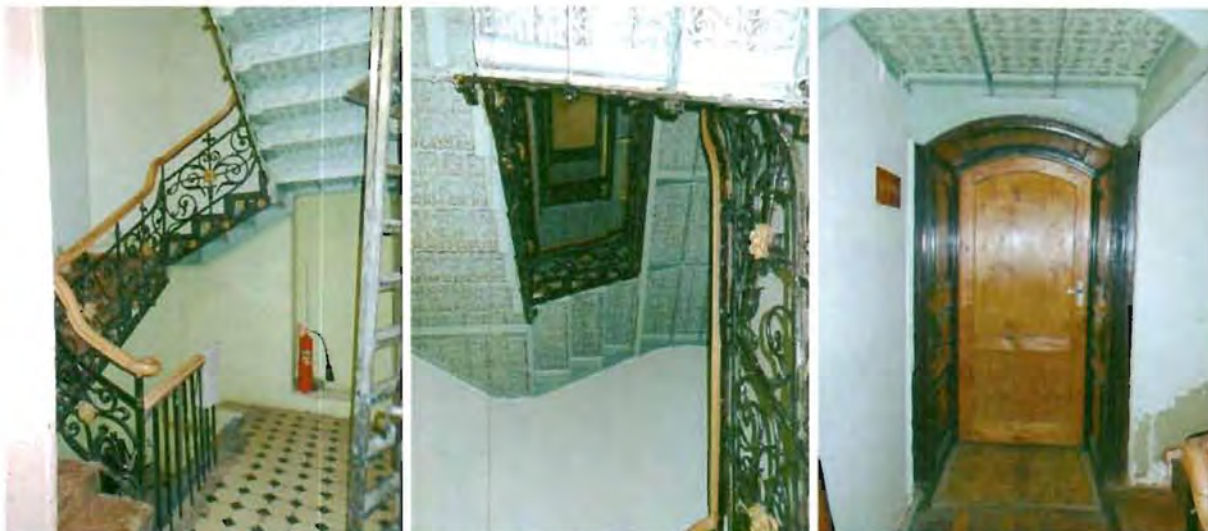
76, 77, 78. Две лестницы в западной и восточной частях боковых дворовых флигелей, коридор 2 этажа поперечного флигеля
