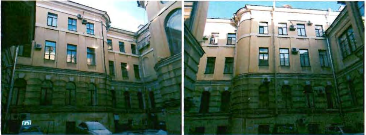
11, 12. Северный двор. Северный и южный фасад
